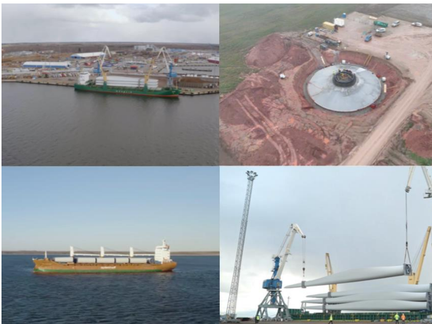
Joonis 14. Komponentide transport ja saabumine sadamasse ning ehitustööd [119], [120]
