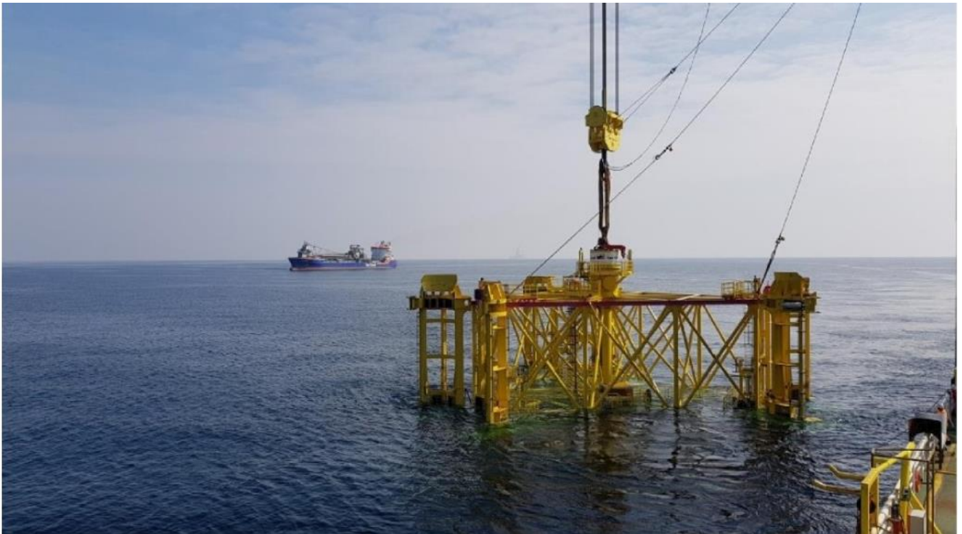
FOTO 2.6-5. VAIADE RAKISE EEMALDAMINE PÄRAST ANKURVAIADE EDUKAT PAIGALDAMIST (ALLIKAS: VAN OORD)
