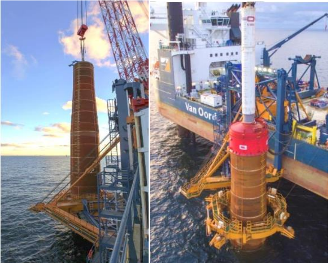
FOTO 2.6-6. PAREMAL FOTOL VAIVUNDAMENT HAARATSIS, VAHETULT ENNE VABASTAMIST KRAANA KÜLJEST. VASAKUL FOTOL VAIVUNDAMET HAARATSIS, SAMAL AJAL KUI HÜDROVASAR SÜVISTAB VAIVUNDAMENDI SOOVITUD SÜGAVUSENI (ALLIKAS: VAN OORD)
