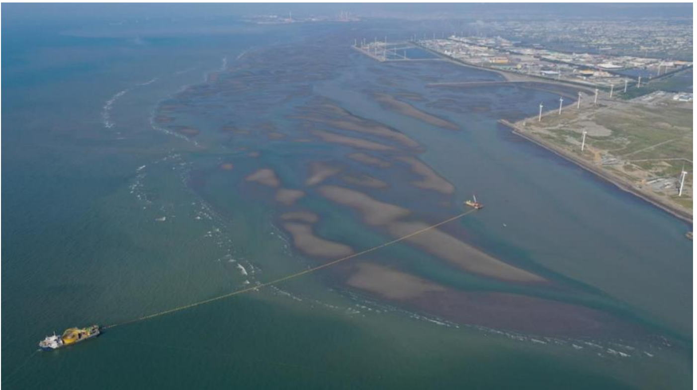
FOTO 2.6-9. NÄIDE KAABLI PAIGALDAMISEST UJUVMEETODIL MADALAS VEES (ALLIKAS: VAN OORD)
