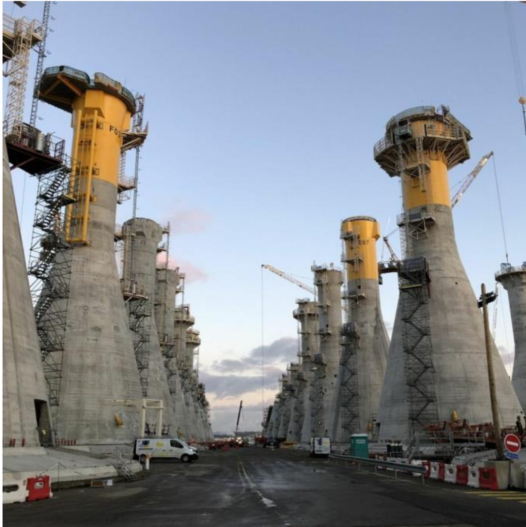
FOTO 2.5-3. FÉCAMPi MERETUULEPARGI GRAVITATSIOONIVUNDAMENDID (ALLIKAS: VAN OORD)
