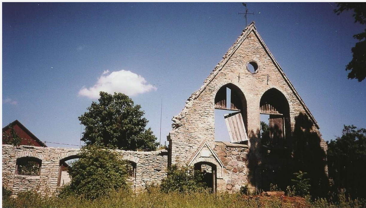
Kohalikust Vasalemma tüüpi “marmorist” Ohtu mõisa tall- tõllakuuri (1888) ja Ruila mõisa kõrvalhoone (1864) varemed
