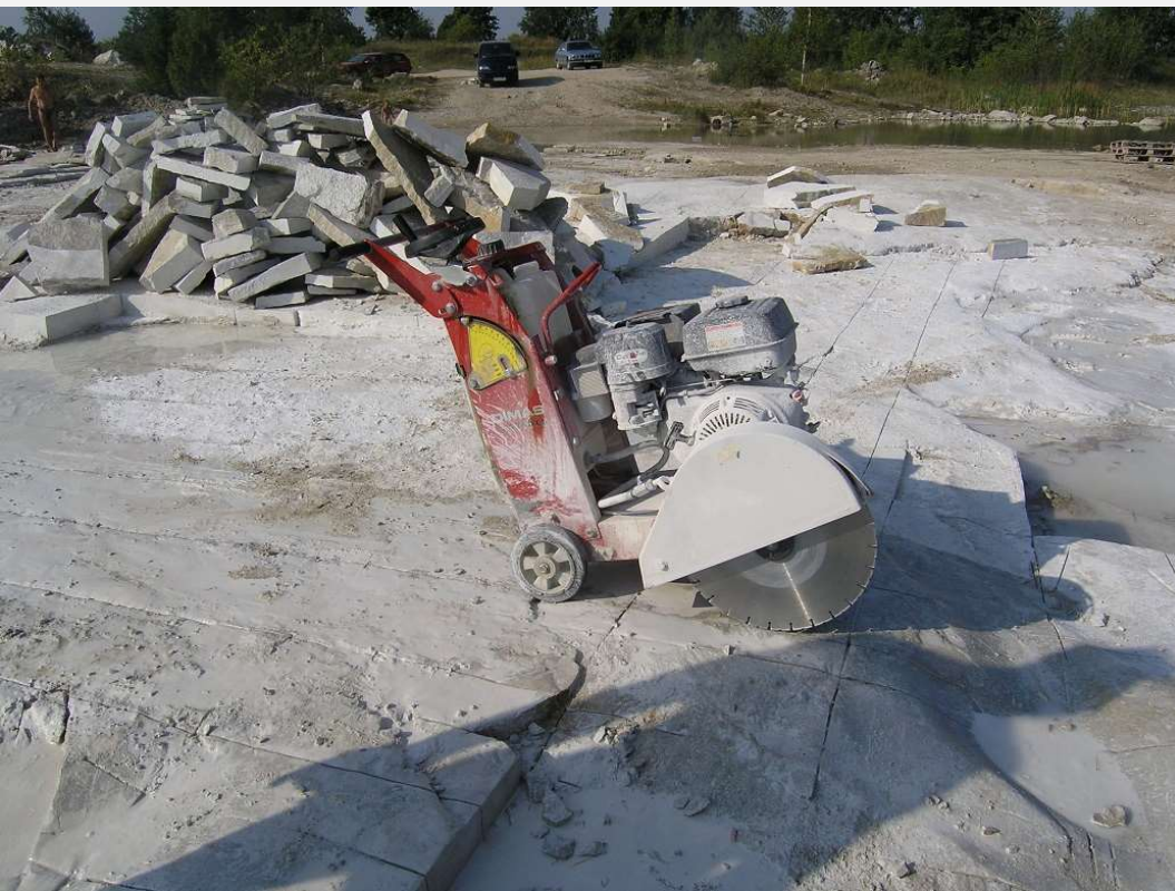
Portatiivne kivilõikemasin ca 2003. a
