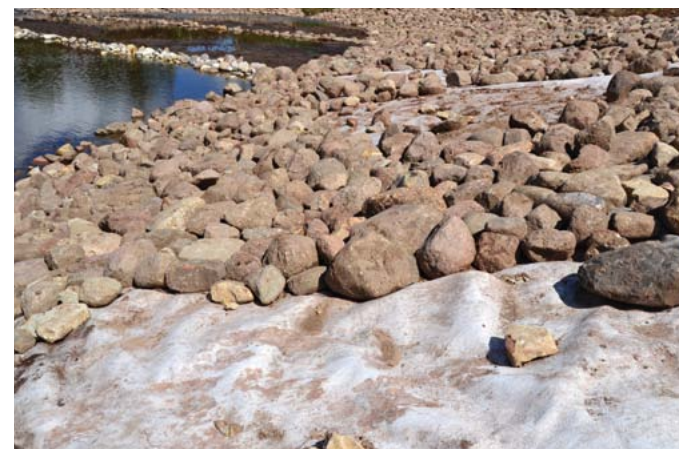
Kaldakindlustuse või paisu ehitamine geotekstiili ja maakive kasutades on kauakestev lahendus ning väldib pinnase ärakannet. Foto: Kuno Kasak
