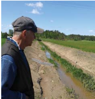
Norsholmi külas Lõuna-Rootsis rajas kohalik põllumees Hubert Gelin koos seitsme maaomanikuga ca 2 km pikkuse kahetasandilise kraavituse. See on Ameerika Ühendriikides küllaltki levinud veekaitsemeede, mida Euroopas ei ole eriti laialdaselt kasutusele võetud. Hubert Gelin on ka 2015. aasta Läänemere-sõbraliku põllumajandustootja Rootsi vooru võitja. Fotod: Anuschka Heeb
