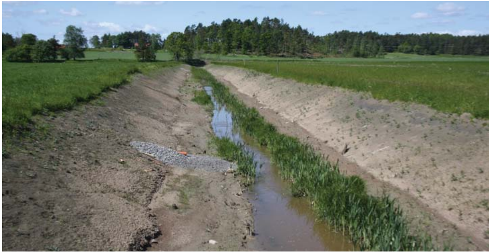
Norsholmi külas Lõuna-Rootsis rajas kohalik põllumees Hubert Gelin koos seitsme maaomanikuga ca 2 km pikkuse kahetasandilise kraavituse. See on Ameerika Ühendriikides küllaltki levinud veekaitsemeede, mida Euroopas ei ole eriti laialdaselt kasutusele võetud. Hubert Gelin on ka 2015. aasta Läänemere-sõbraliku põllumajandustootja Rootsi vooru võitja. Fotod: Anuschka Heeb
