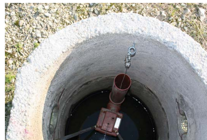
Kohas, kus kuivendustoru väljub lahtisesse peakraavi, on kasutatud lihtsamat lahendust. Toru otsa võib ilma tööriistu kasutamata asetada kas otsapidi püsti nagu korstna või pikali maha. Esimesel juhul tõstetakse pinnasevee tase kõrgemale, viimasel juhul aga võimaldatakse liigvee kiire äravool. Foto: Kristjan Piirimäe
