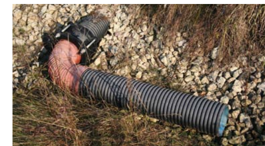
Kohas, kus kuivendustoru väljub lahtisesse peakraavi, on kasutatud lihtsamat lahendust. Toru otsa võib ilma tööriistu kasutamata asetada kas otsapidi püsti nagu korstna või pikali maha. Esimesel juhul tõstetakse pinnasevee tase kõrgemale, viimasel juhul aga võimaldatakse liigvee kiire äravool. Foto: Kristjan Piirimäe
