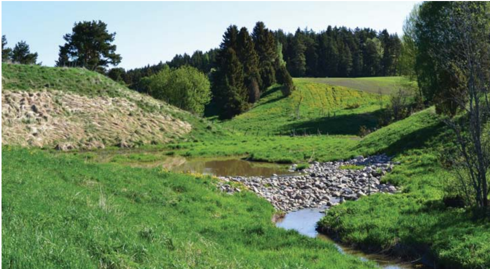
Põllumajanduslikku hajureostust puhastav ca 2000 m 2 suurune avaveeline tehismärgala Soomes eemaldab tõhusalt nii toit- kui ka hõljuvaineid. Märgala on rajatud kruusast paisu abil, mis on kindlustatud geotekstiili ning maakividega. Paisu rajamine kraavile on kiire ning küllaltki odav viis luua märgala, kuid peab arvestama, et ülesvoolu ei tohi paisutusel negatiivset mõju olla, eeskätt kuivendusele. Foto: Kuno Kasak
