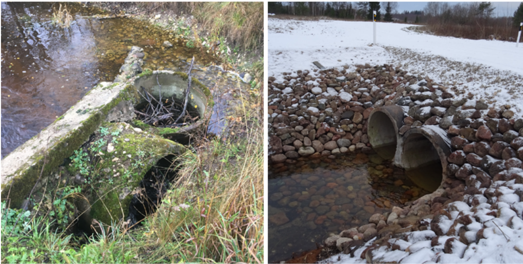
Mitmed teetruubid olid varasemalt Jänijõe valgalal sedavõrd halvas olukorras, et muutusid juba ohtlikuks (vasakul). Hooldustööde käigus taastati lagunened truubid ning kindlustati geomembraani ja maakividega.
