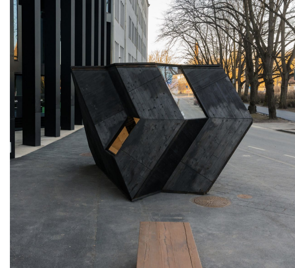
Moodul bussijaam ELEMENTaarne bussipeatus, toodetud CLT paneelidest, rakendades varieeruvust minimaalsel määral.
