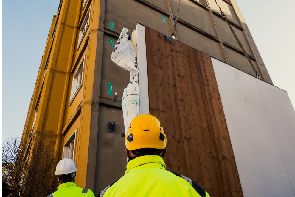
Thermory laudise paigaldamine Annelinna fassaadile. Sügis 2023. BuildEST LIFE IP
