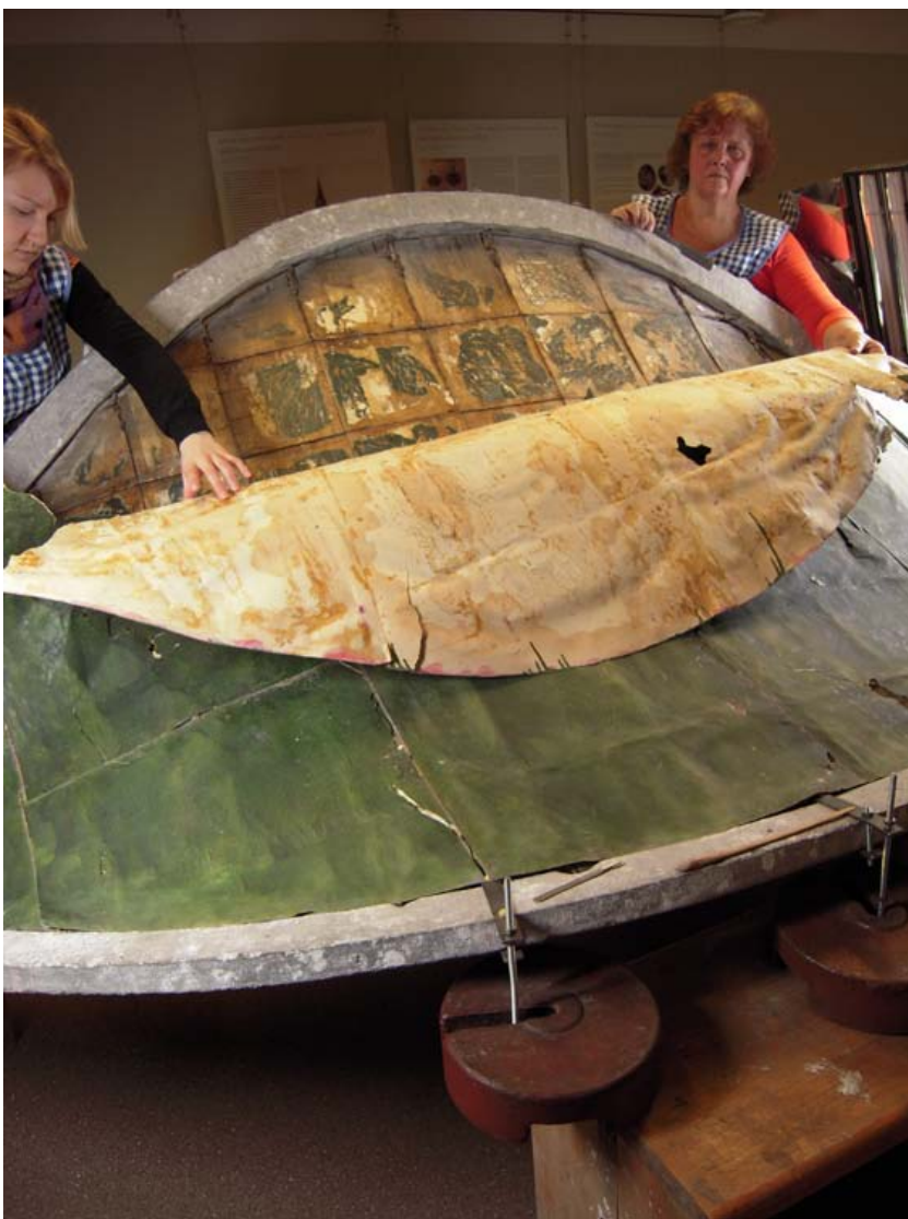
Ill 23. Mudeli katusepaber eemaldati kuivalt, spaatlite ja skalpelli abil.
