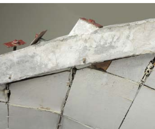
Ill 14. Niiskusest kahjustunud vineer ja metalltraadid enne konserveerimist.
