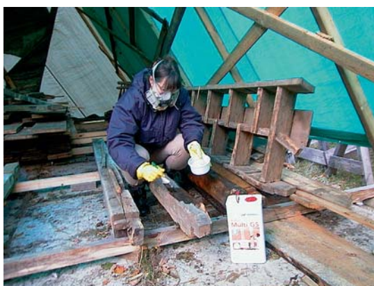
Ill 6. Puitulagundavatest seentest nakatunud puidu töötus Aidol Multi GS-iga 2005. aasta oktoobris.
