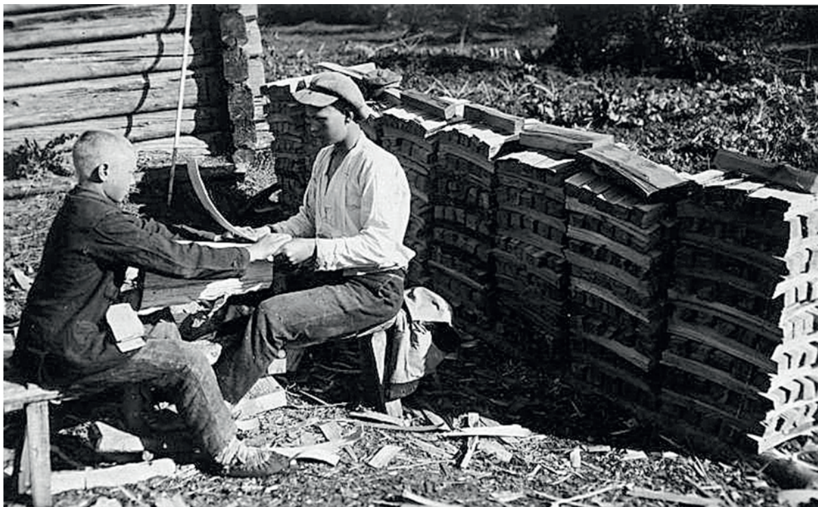
Poisid pingil pilpaid valmistamas: parempoolne surub lõmmu (kandidud toorik) jalgadega kinni ja tõmbab liimeistrit, noorem poiss aitab lükata. Valmis pilpad on seatud kümne kaupa riita. Foto 1920ndaist, Jaan Vali erakogu.
