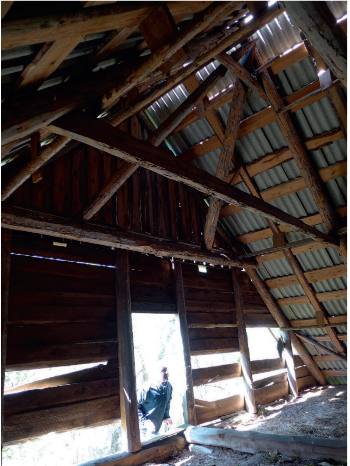
Poolkelpkatus, mis on eterniidiga katmisel muudetud viilkatuseks. Foto: Joosep Metslang.
