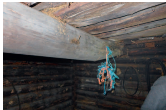
Deformeerunud laetala on ületanud kandepiiriseisundi. Foto: Joosep Metslang.
