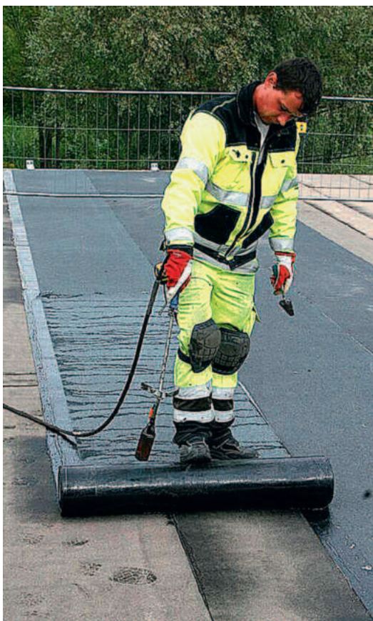
Hüdroisolatsiooni pealiskihhi paigaldamine uue Eesti Rahva Muuseumi katuse aluskihile. Gaasipõletit sulatab rulli aluspinnal oleva keevisbituumeni, pealiskihht nakkub aluskihiga. Foto: Alo Karu.
