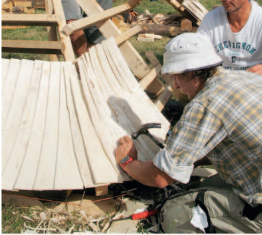
Kelba keeramisel voolitakse laastud ülevalt teravaks. Räästajoonel tekib väike tõus: keeramisel peab laaste roovi suhtes veidi tõstma. Foto: Joosep Metslang.
