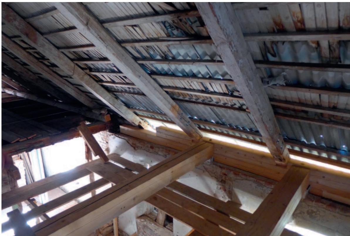
Asendamisel talad, müürlatt ja sarikate proteesid. Foto: Joosep Metslang.
