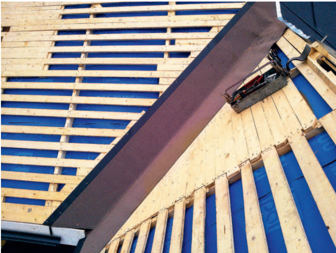
Täiendav hüdroisolatsiooniga neel. Foto: Kalvi Kondio.
