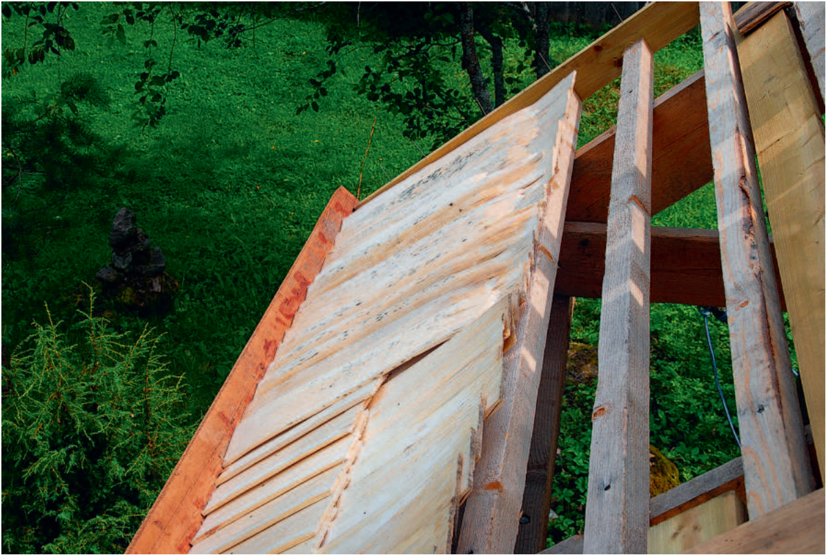
Et read oleksid sirged ja laastud alla ei vajuks, kasutatakse paigaldamisel rihtlauda. Foto: Targo Kalamees.
