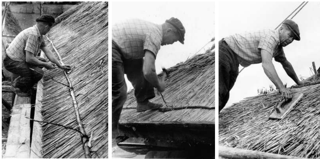
Esimeste kahlude kinnitamine korralatiga; korralati pingutamine; katusepinna tasandamine. 1960–1970ndad. Fotod: Lembit Odres.
