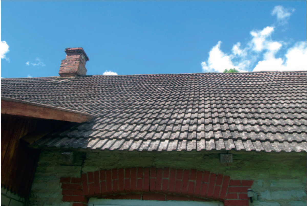
1930. aastail ehitatud, Märjamaa vallas asuva pikkmaja hea betoonkivikatus peab tänaseni vastu. Vastupidiselt toona soovitatule pole alumist roovi tõstetud: esimese rea kivid on madalama nurga all. Kivide püstvaltsid ei ole nihkes, ent katus peab siiski kenasti vett. Harva sarikasammuga katuse roovid on paindunud, kuid katus peab vastu. Foto: Joosep Metslang.
