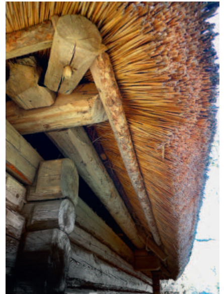
Kui külgeinad on põhiplaani kõverad, saab murispuud taladele toetades teineteise suhtes rõõpseks seada. Foto: Joosep Metslang.
