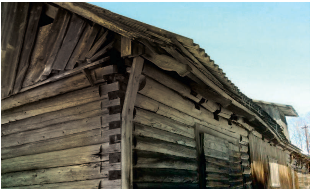
Deformeerunud laetala on ületanud kandepiiriseisundi. Foto: Joosep Metslang.
