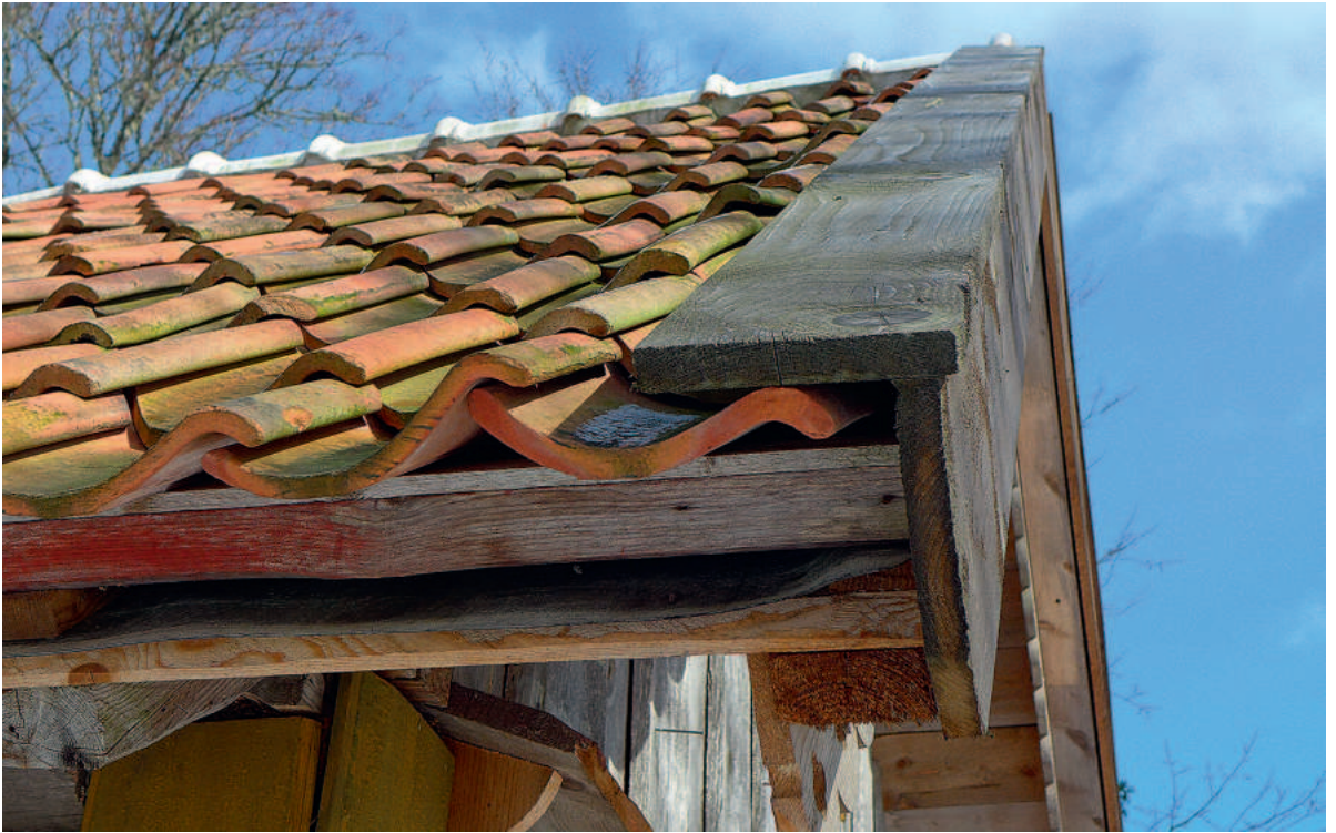
Rullmaterjaliga kaetud aluskatuse vormistus räästal, viilul ja harjal. Foto: Joosep Metslang.
