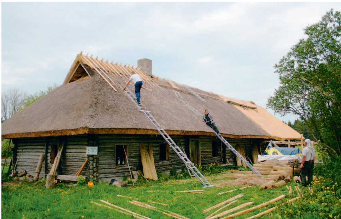
Rehemaja roogkatte valmistamine Hiiumaal Pühalepa vallas. Foto: Siim Sooster.
