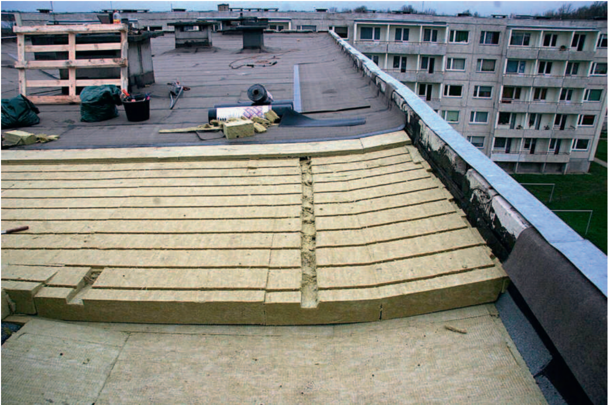
Soojustuse ja hüdroisolatsiooni aluskihi paigaldamine. Foto: Alo Karu.
