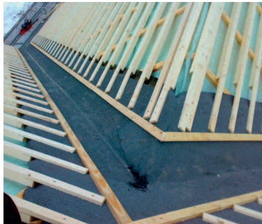
Bituumenrullmaterjalist neelu valmistamine. Foto: Janek Käär.
