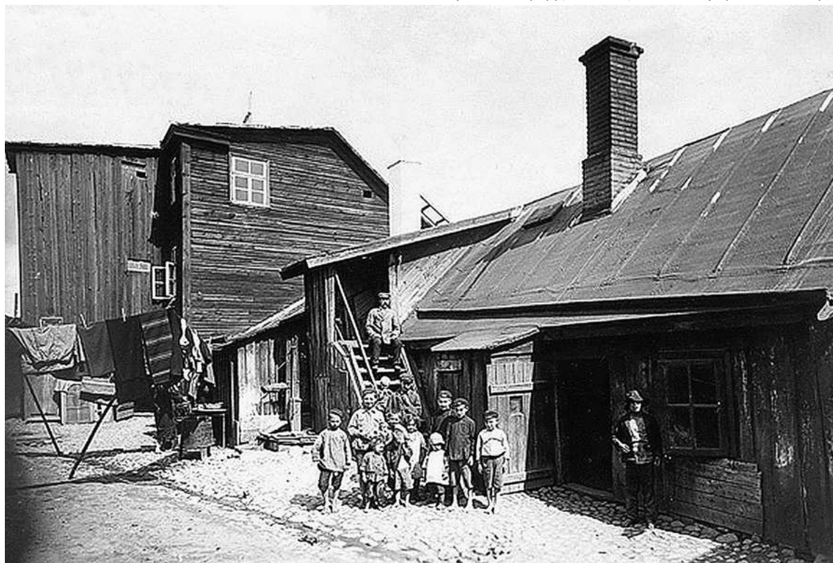
J. Pääsukese fotol on näha pikki katusepappipaane, mille kinnitamiseks on muu seas kasutatud kolmnurkseid liiste. Sarnast kinnitustehnikat kohtab tänaseni Skandinaavias. Foto: Eesti Rahva Muuseum.
