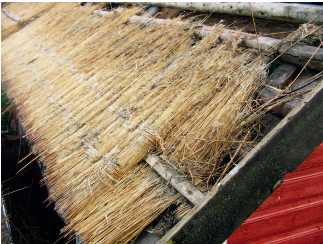
Räästa valmistamine õlevihkudega. Hoone Vormsi saarel. Foto: Siim Sooster.
