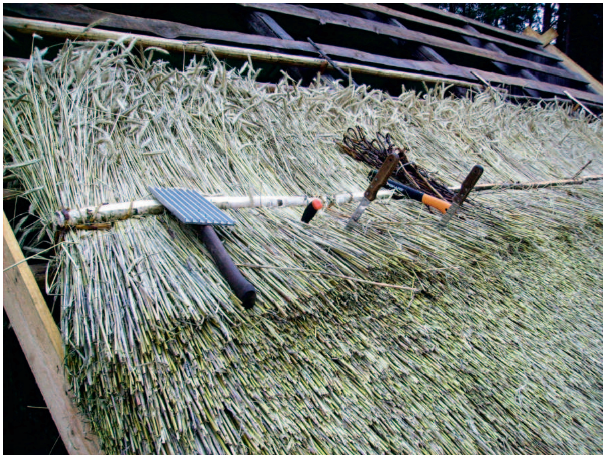
Õlgkatuse tegemine Malvastes Hiiumaal, fotol näha korralatt. Foto: Siim Sooster.
