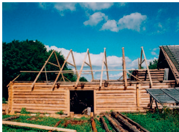
Lääne-Virumaal Sallas restaureeritud rehemaja uus katusetarind valmis palkidest. Foto: Mart Lankots.
