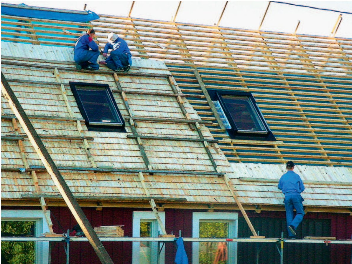
Sindlite paigaldamine. Foto: Janek Käär.
