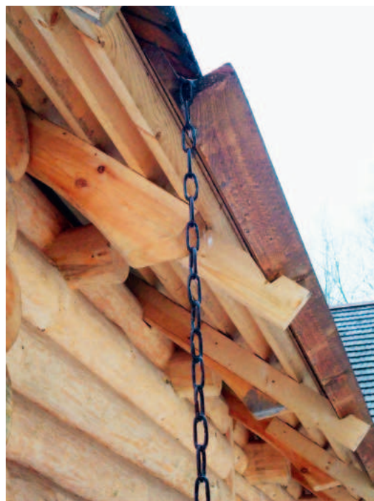
Puidust katuserenn ja kett. Foto: Joosep Metslang.
