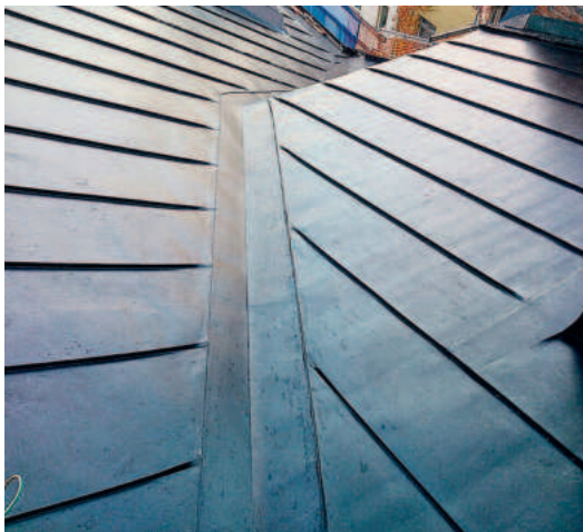
Valmis neel. Vasakpoolne neeluvalts on lamava ja parempoolne püstise topeltvaltsiga. Foto: Kalvi Kondio.
