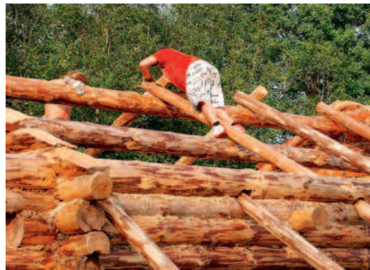
Sarikapaari kinnitamine harjalt. Foto: Viire Kobrusepp.
