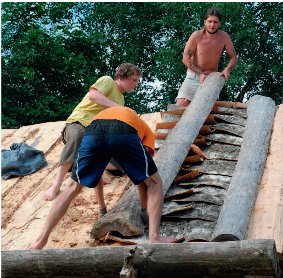
Pindlauda sättimine kasetohu peale. Foto: Viire Kobrusepp.
