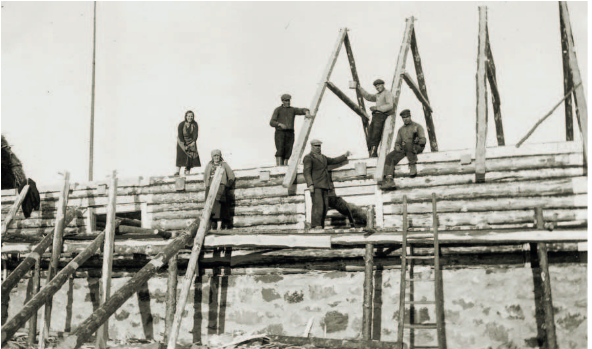
Lauda katuse ehitus 1920.-1930. a Läänemaal: talad jooksevad ühte, sarikad teist sammu. Foto: Lea Nappus, August Pikjalg.
