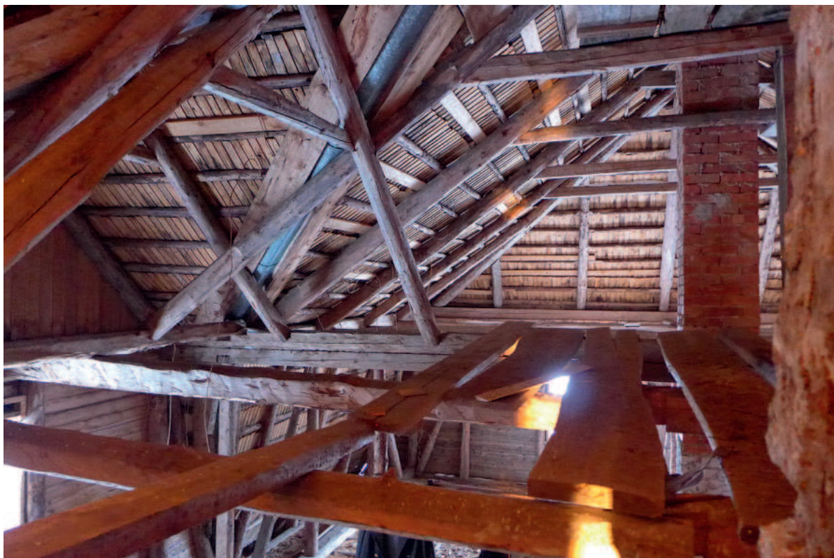
Fotol eelmise lõike mansardkatuse ülaosa. Põhihoone sarikad ristuvad vasemal uugi sarikatega. Neelu tugevdamiseks on sarikatele kinnitatud kaks planku, mis jäävad roovidega samasse tasapinda. Mõlema hooneosa murispuud on samas tasapinnas, uugi hari jääb põhihoonest veidi allapoole. Foto: Joosep Metslang.
