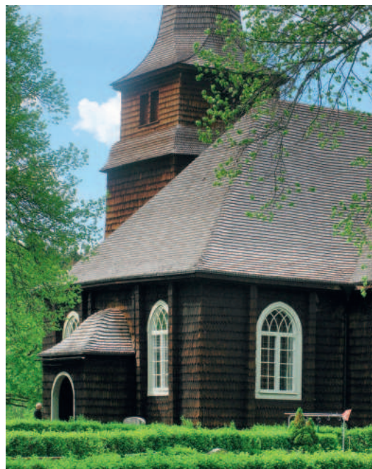
Östmarki kirik Rootsis Värmlandis. Põhjamaadel on kimmkatuse säilimisele juba aastatuhat kaasa aidanud tõrvamine. Seda traditsiooni on näha näiteks vanade kirikute katustel ja fassaadidel. Hea puiduvaliku, korraliku hooldamise ja tõrvamise korral võib kimm säilida sajandi ja kauemgi. Foto: Joosep Metslang.
