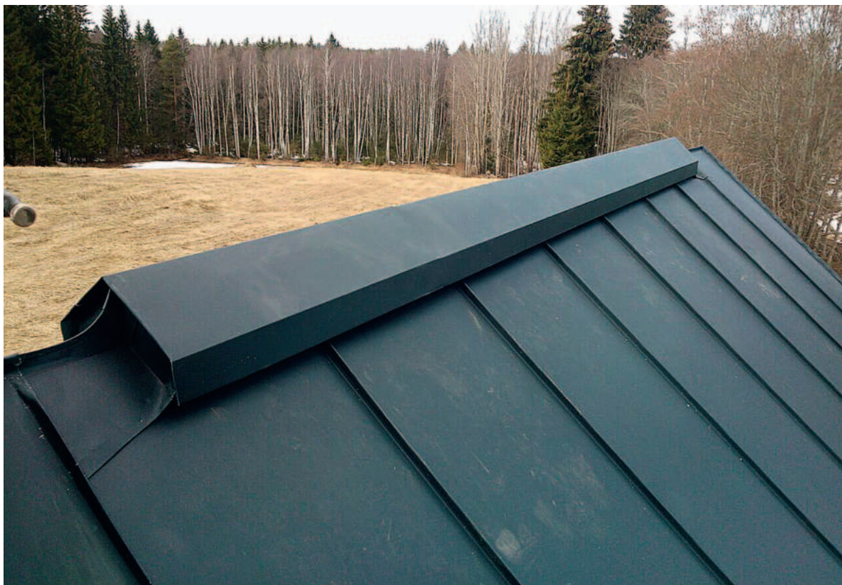
Tuulutatava harjaga valtsplekk-katus. Foto: Kalvi Kondio.
