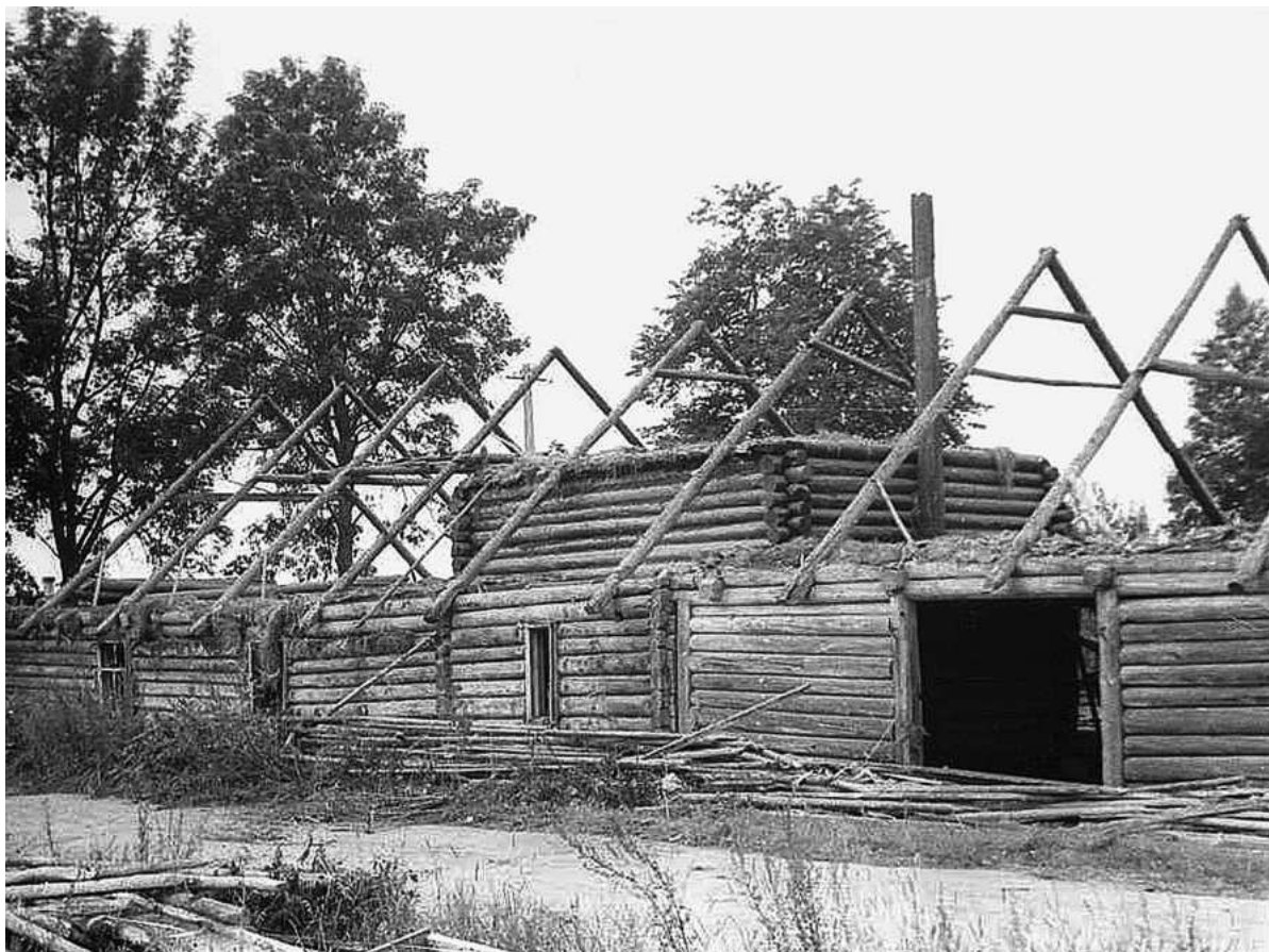
Reiera talu rehemaja Avinurme lähedalt. Vähem täpsust nõudvate kergete katete jaoks on veidi kõver katusetarind täiesti sobiv. Kuidas ja kas sellisele majale on tarvis uut tikksirget katusetarindit? Foto: Eesti Vabaõhumuuseum.
