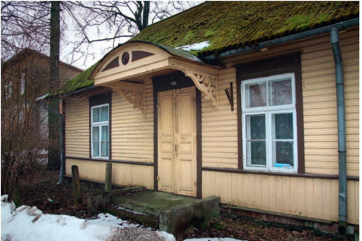
Hoonel Laiuse alevikus on sissepääsu kohal kumer varikatus, mida ehivad taimornamendiga konsoolid. Foto: Joosep Metslang. Šveitsi stiilis aida räästaalune Kõrgemäe talus Mulgimaal. Foto: Heiki Pärdi.
