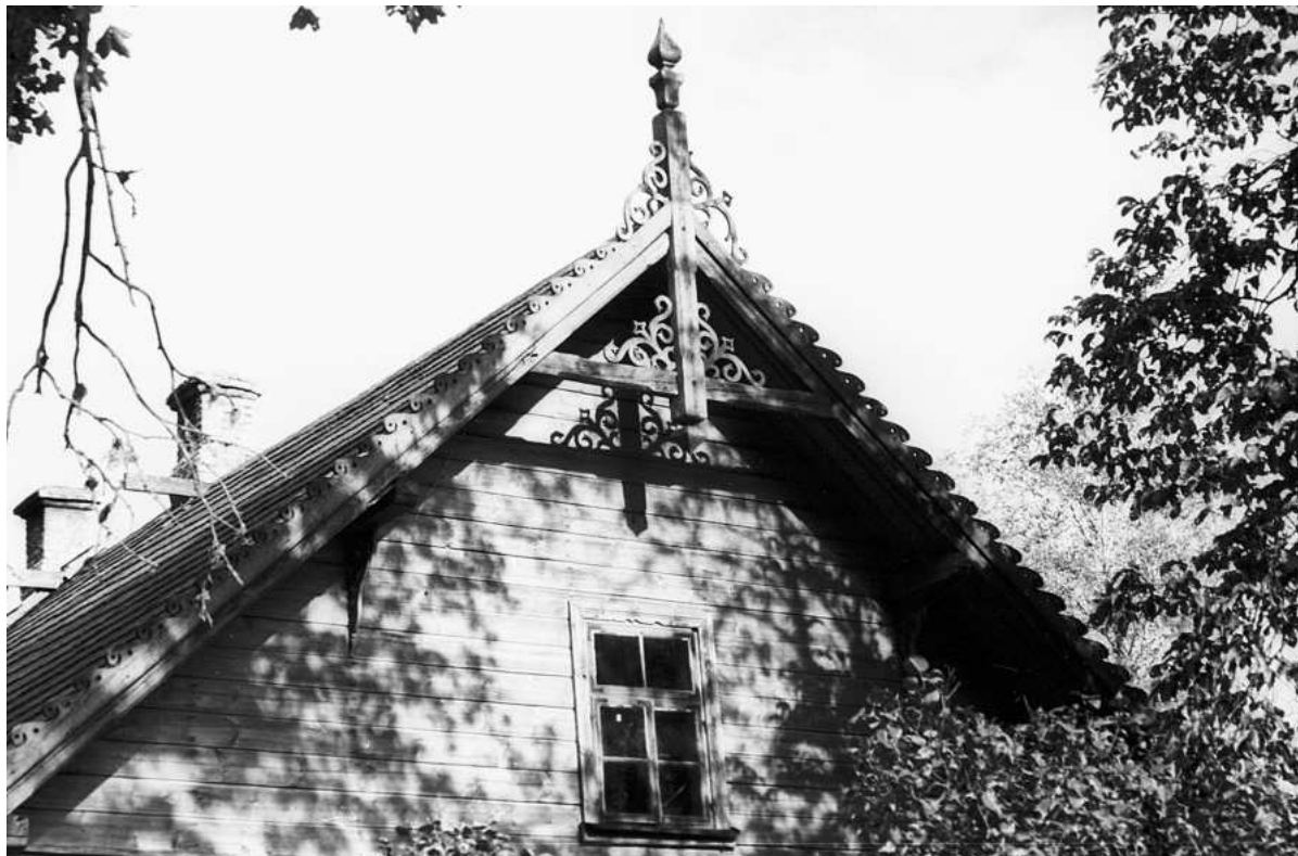
Järvakandi vallas Lihuveski talu elumaja rippviilul on ehispenn ja varras. Viilulauad on lõigatud taimornamendikujuliseks. Foto: Karl Tihase.
