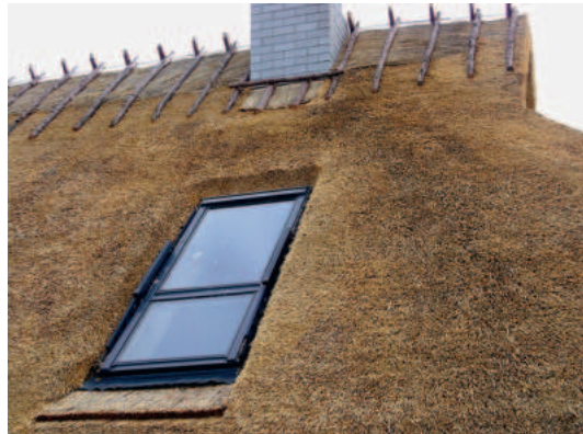
Katuseakna vormistus katusel. Foto: Siim Sooster.
