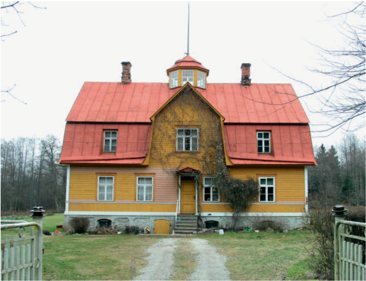
Tapurla küla Sameli talu. 1926. a ehitatud esinduslik piiritusekuninga elumaja torkab silma mitme ebatavalise nüansiga, sh kauni proportsiooniga mansardkatuse, keske suure ärkli ja ilmselt Eesti taluarhitektuuri ainukese katuselaternaga. Foto: Heiki Pärdi.
