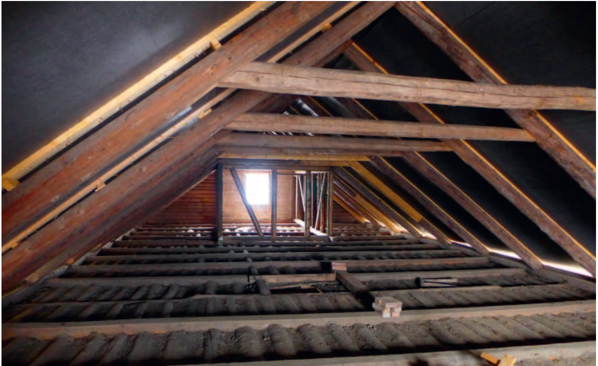
Sindelkatte alustasapinna rihtimine. Rihtlaudadele on asetatud aluskate, mille kohale on kinnitatud distantsiistud, roovitus ja sindlid. Foto: Joosep Metslang.
