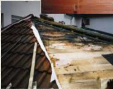
Abb. 4.10: Lösung des Versatzes durch gezielte Fällenschnitte in der Schalung bei UST/ST/ST/ST
