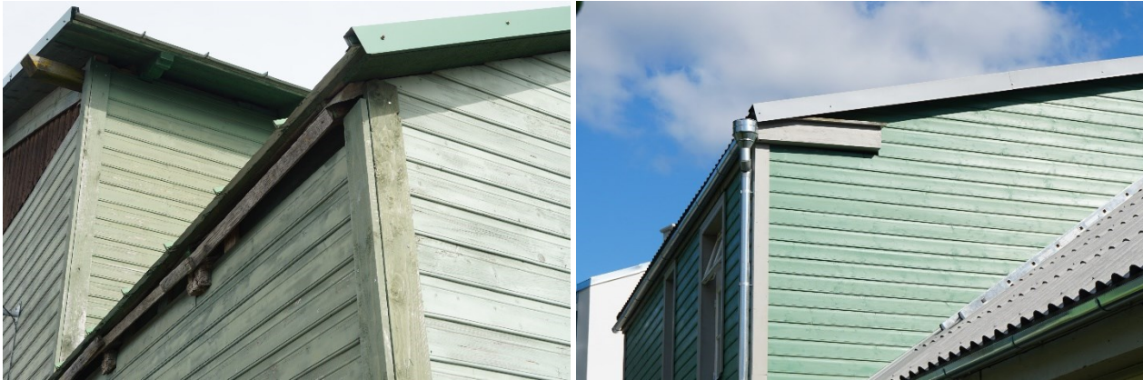
Joonis 4 Eramu, mille katus on vahetatud ja sein soojustatud, kuid räästa pikkus nii otsa- kui ka külgseinte kohal on jäänud olematuks ning tuulekast on lahendamata (vasakul). Elamu vintskapi katus vahetati varem ja seinad soojustati piiratud ulatuses hiljem (paremal).
