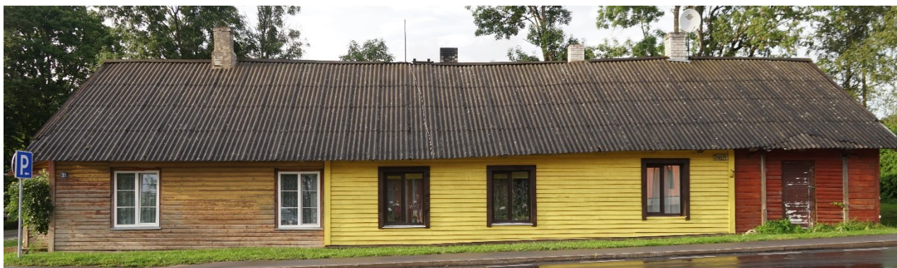
Joonis 3 Elamu kaks omanikku on vahetanud aknad erineva lahendusega ja üks omanik on uuendanud voodrit algupärasest oluliselt erineva lahendusega, soojustus seal all on minimaalne.
