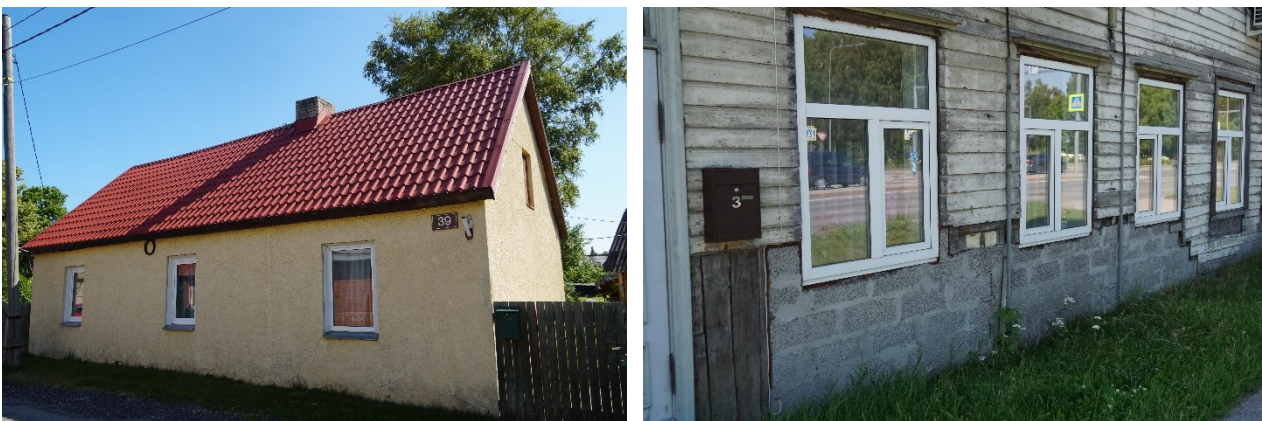
Joonis 1 Eramu, mille katus on vahetatud, kuid räästa pikkus ei otsa- ega ka külglise kohal pole piisav, et fassaadi renoveerimisel saaks sein märkimisväärselt paksemaks ehitada (vasakul). Paremal hoone, mille fassaad on renoveerimata, kuid on paigaldatud uued aknad. Fassaadi renoveerimisel on tarvis aknad tuua soojustuse kihti.
