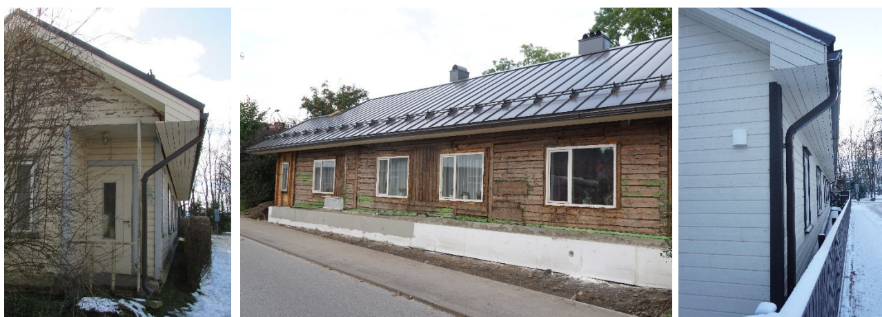
Joonis 5 Eramut renoveeriti etapiti mõne aasta pikkuste vahedega: pärast katusevahetust oli räästas ebalooslikult pikk (vasakul), keskel avatud fassaad ja paremal tulemus pärast fassaaditööd.
