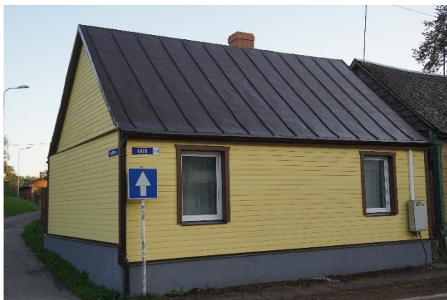
Joonis 2 Etapiviisiline renoveerimine eramul: kõigepealt on vahetatud aknad ning seejärel soojustatud fassaad ja sokkel, katus on ainult värvitud ja pikendatud (paremal).
