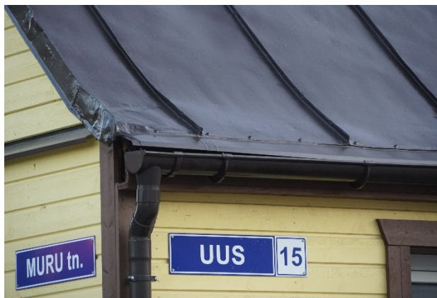
Joonis 2 Etapiviisiline renoveerimine eramul: kõigepealt on vahetatud aknad ning seejärel soojustatud fassaad ja sokkel, katus on ainult värvitud ja pikendatud (paremal).
