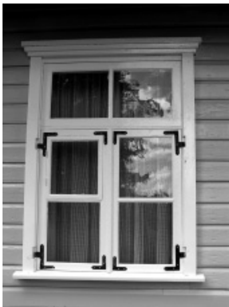
Rõhtlaudisega renoveeritud hoonele on pandud uued akna piirdelauad ja nurgikud. EL
