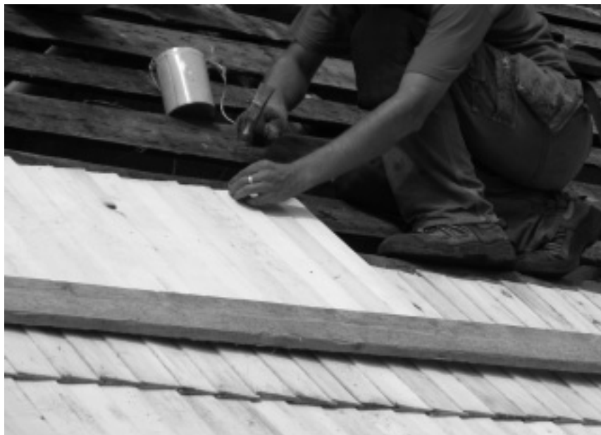
Sindelkatuse tegemine. Sindlil on kiilukujuline lõige ja soon, mille sisse järgmine sindel asetatakse. JM
