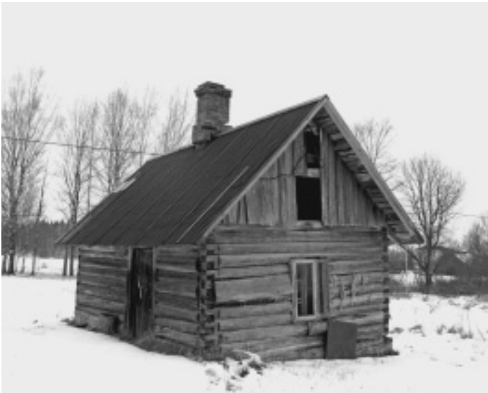
Palgist puhasvuugia soome saun. Rahuldavas olukorras korrastamist vajav hoone on madala betoonsokliga ja tõrvapapiga kaetud viilkatusega. JM
