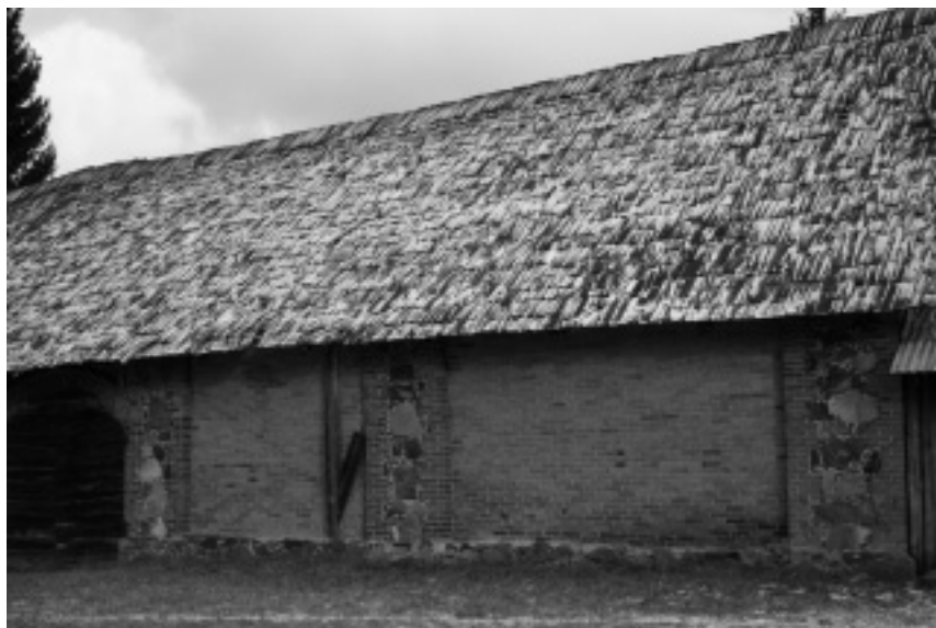
Tellisseintega kõrvalhoone, seinakonstruktsiooni kandvamad osad on laotud maakividest. EL
