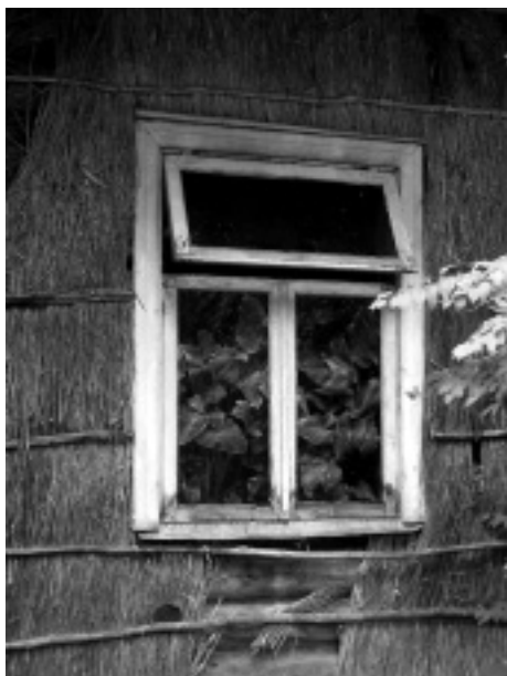
Hoone soojustamiseks on kasutatud roomatte. EL
