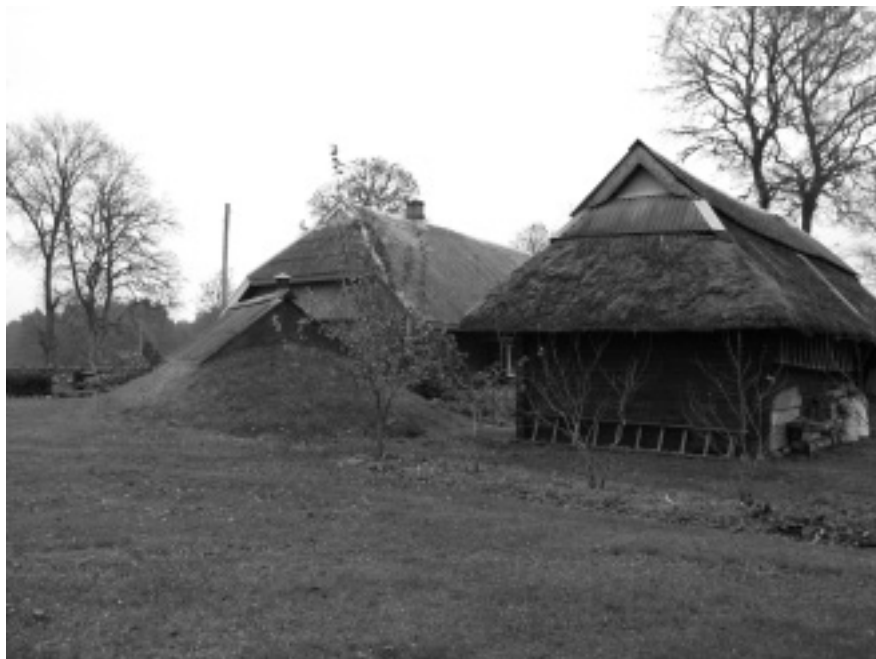
Kolm Eestis enamlevinud katusetüüpi Saaremaalt: vasemal viiluga kelder, selle taga poolkelpkatusega rehemaja ja paremal kelpkatusega ait. Kahel viimasel on unka-augud. JM
