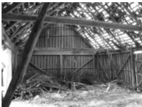
Prussidest sõrestikseintega küün. Halvas olukorras hävinev hoone on ehitatud nurgakividele. JM
