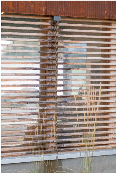
Joonis 6. Vihmaveesüsteemis on vihmaveetoru asendatud ketiga (vasakul), süliiti paigaldatud kandvale postile (keskel), ja sillutiselt pritsib vesi kandva posti kinnitussõlmele (parem)
