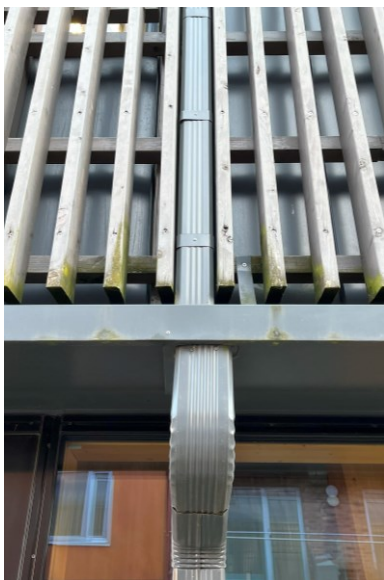
Joonis 11. Raskesti hooldatav vihmaveesüsteem ribiseina all. Renni kogunenud sodi on aja jooksul muutunud huumuseks.
