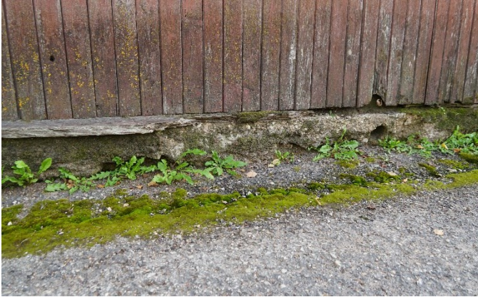
Joonis 2 Asfaldilt pritsiva vee tõttu pehkinud veelaud ja laudvooder (vasakul) ning veelaud vertikaal- ja horisontaalvoodri vahel samal hoonel (paremal).
