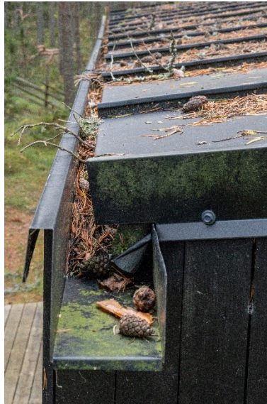
Joonis 10. Intensiivse hooldusvajadusega kohas paiknev peidetud vihmaveesüsteem. Kitsa hoolduspiluga vihmaveerenn on ummistunud.
