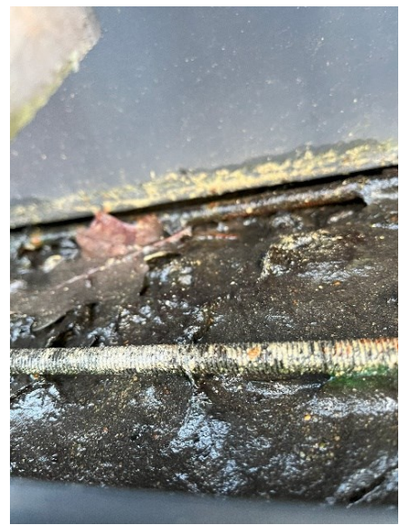
Joonis 11. Raskesti hooldatav vihmaveesüsteem ribiseina all. Renni kogunenud sodi on aja jooksul muutunud huumuseks.
