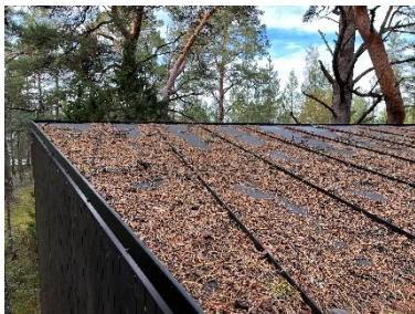
Joonis 10. Intensiivse hooldusvajadusega kohas paiknev peidetud vihmaveesüsteem. Kitsa hoolduspiluga vihmaveerenn on ummistunud.
