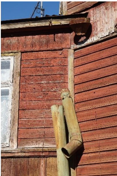
Joonis 5 Lagunenud vihmaveetorud.
