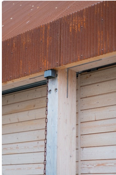
Joonis 6. Vihmaveesüsteemis on vihmaveetoru asendatud ketiga (vasakul), süliiti paigaldatud kandvale postile (keskel), ja sillutiselt pritsib vesi kandva posti kinnitussõlmele (parem)
