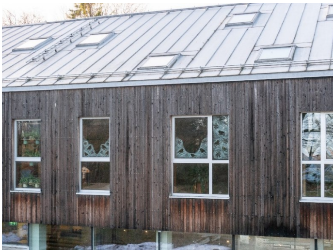
Joonis 9. Ilma räästata hooned, millel on vihmaveerennid kohe fassaadikatte materjali kohal. Näha on, et fassaadi niiskuskahjustused on lokaalsetes piirkondades ulatuslikumad kui ülejäänud fassaadipinnal.
