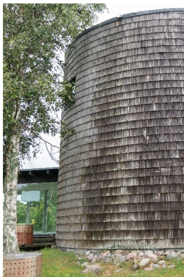
Joonis 7. Vihmaveesüliiti kahekorruselise hoone ilma räästata katusel.
