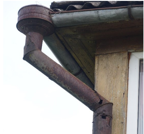
Joonis 4 Auklikuks korrodeerunud vihmaveerenn (vasakul) ja vihmaveetoru (paremal).
