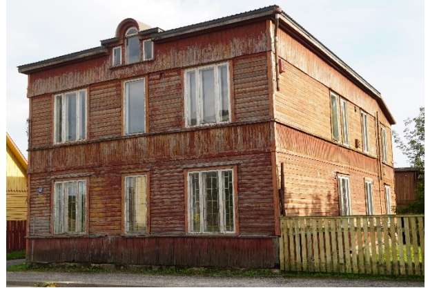
Joonis 2 Asfaldilt pritsiva vee tõttu pehkinud veelaud ja laudvooder (vasakul) ning veelaud vertikaal- ja horisontaalvoodri vahel samal hoonel (paremal).
