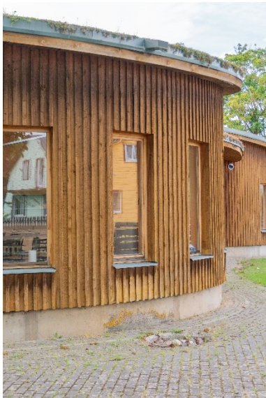
Joonis 8. Vihmaveesüüti ühekorruselise hoone räästaga katusel (vasakul), kust alla voolav vesi pritsib munakivisillutiselt soklile ja fassaadi alumisele äärelle (paremal).
