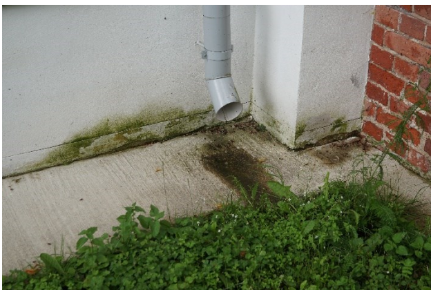
Joonis 3 Pärast hoone renoveerimist on vihmaveetorude alla betoonpanduse sisse jäetud madalad rennid (vasakul), milles mõnele on hiljem lahtiselt peale lisatud tehases toodetud betoonist vihmaveepüüdja (paremal).
