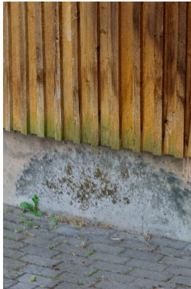
Joonis 8. Vihmaveesüüti ühekorruselise hoone räästaga katusel (vasakul), kust alla voolav vesi pritsib munakivisillutiselt soklile ja fassaadi alumisele äärelle (paremal).
