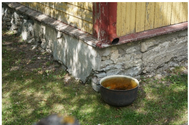
Joonis 1 Liiga kõrgest vihmaveetoru otsast tingitud pritsimine on uhtunud kivide vahed mördist tühjaks (vasakul).
