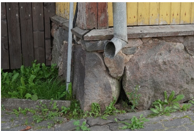
Joonis 1 Liiga kõrgest vihmaveetoru otsast tingitud pritsimine on uhtunud kivide vahed mördist tühjaks (vasakul).
