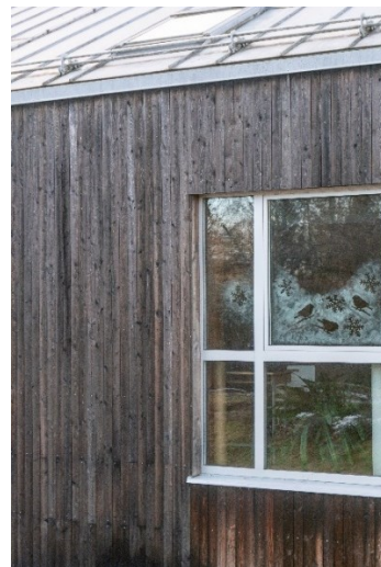
Joonis 9. Ilma räästata hooned, millel on vihmaveerennid kohe fassaadikatte materjali kohal. Näha on, et fassaadi niiskuskahjustused on lokaalsetes piirkondades ulatuslikumad kui ülejäänud fassaadipinnal.
