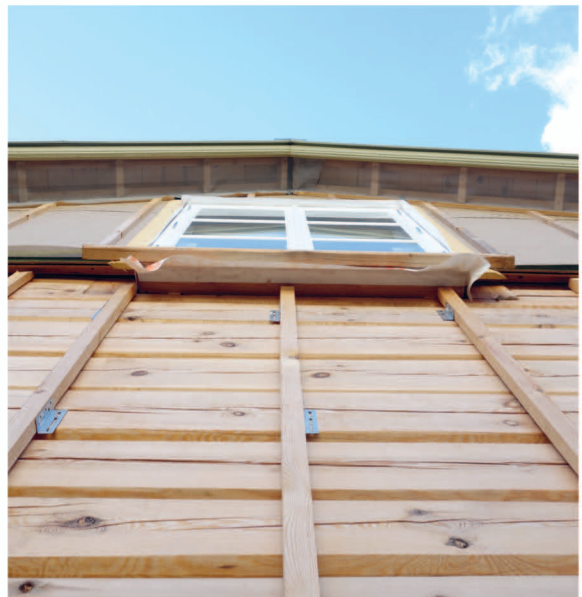
Soojustuse püstlaagid on kinnitatud spetsiaalsete palkseina vajumist võimaldavate ehitusnurkadega.
