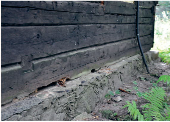
Hoone alumine palk oli pehkinud umbes 10 cm ulatuses.
