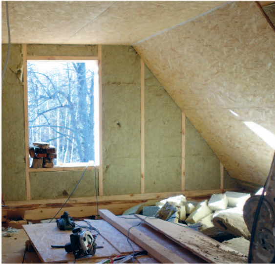
Soojustus kaeti tappühendusega OSB puitlaastplaatidega ja viimistleti tapeediga.
