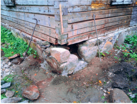
Külmakerke tagajärjel lagunenud sokliosa.
