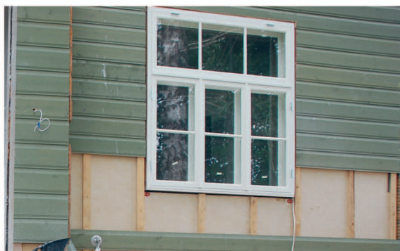
Aken asetseb välisvoodriga samas tasapinnas, et säilitada ajaloolist välisilmet.
