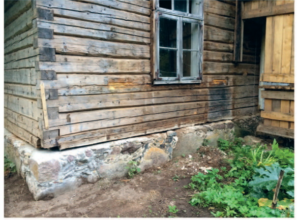
Taastatud sokkel enne palgiparandustöid.
