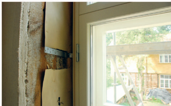
Lengid kinnitati seina külge montaazhilindiga. Ümbrys viimistletakse lengilaiendustega.
