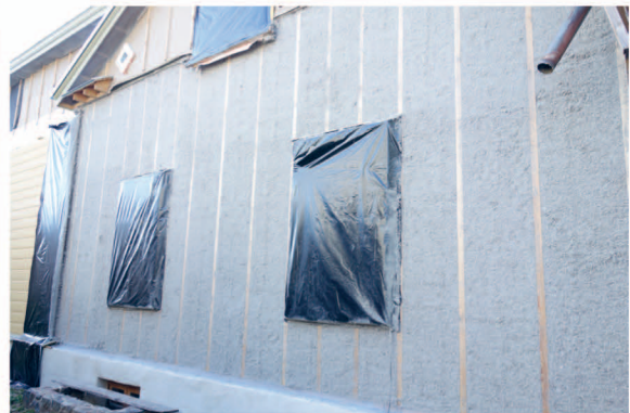
Vasakpoolne pilt. Tselluvilla paigaldus. Parempoolne pilt. Sein pärast tselluvilla paigaldust.
