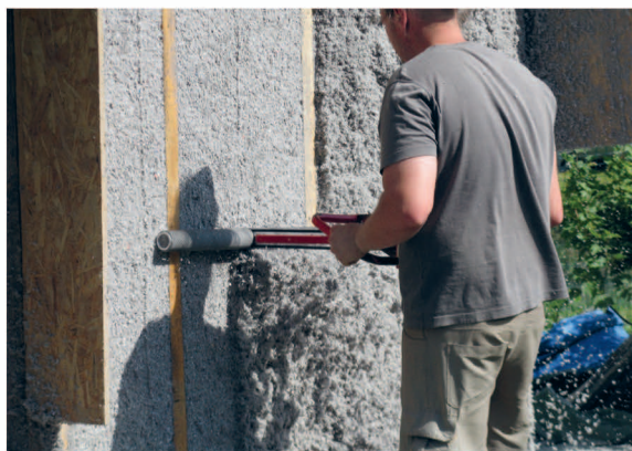
Märgpaigaldatud tselluvill freesitakse seinas ühtlaseks.
