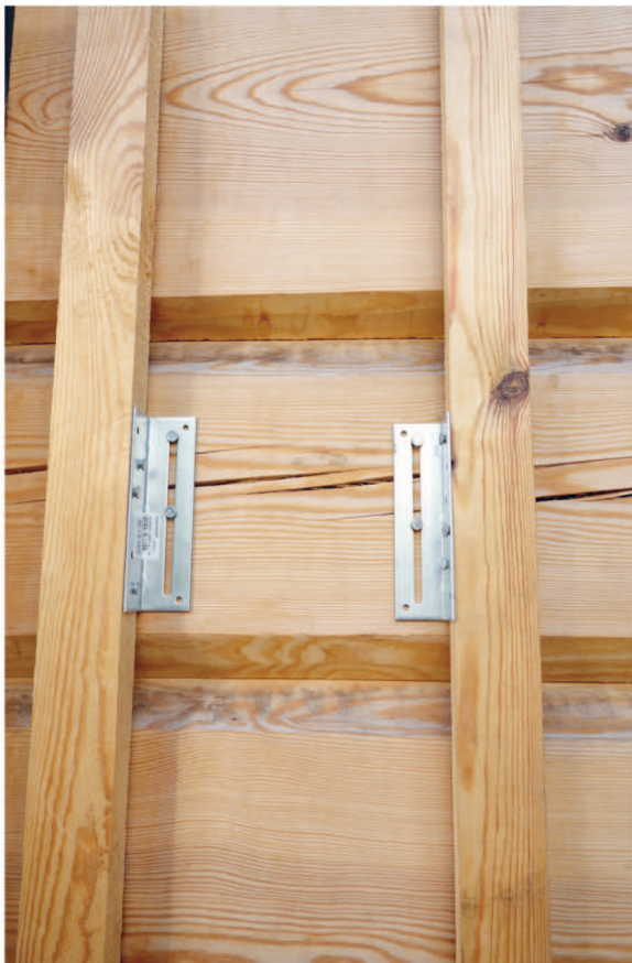
Soojustuse püstlaagid on kinnitatud spetsiaalsete palkseina vajumist võimaldavate ehitusnurkadega.
