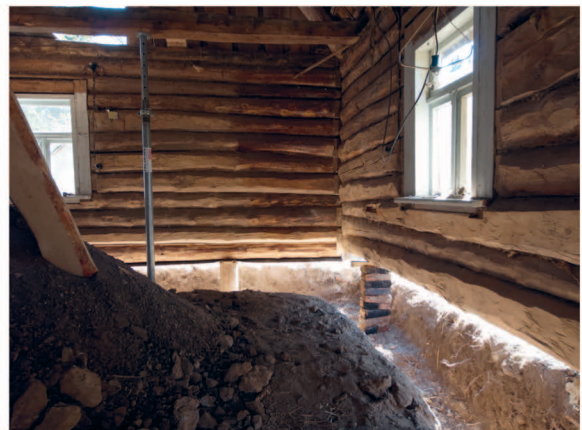
Tööde seis peale palgivahetust ja enne taldmiku saalungite tegemist.
