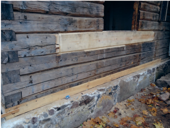
Sokkel ja sein peale palgiparandusi.
