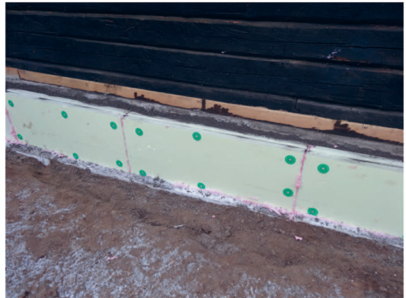
Sokkel pärast soojustuse paigaldamist, enne krohvimist.
