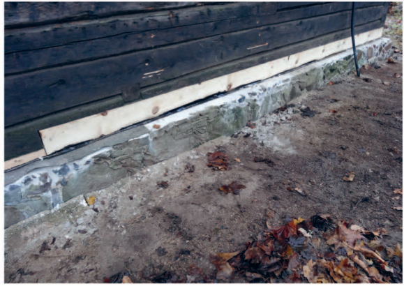
Pehkinud osa palgist eemaldati ja asendati samas moodsus saematerjaliga, töö käigus paigaldati puidu ja vundamenti vahele hüdroisolatsiooni lint.
