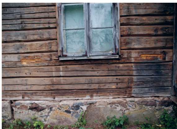
Tüüpilised kahjustuste kohad on alumine palk ja akende alumine osa.
