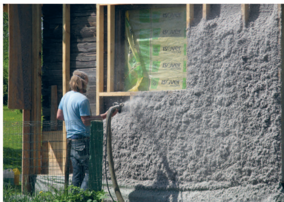
Soojustusmaterjali paigaldamine. Puistevilla eelis on see, et täidetud saavad ka kõik paigavahed ja suuremad praod.
