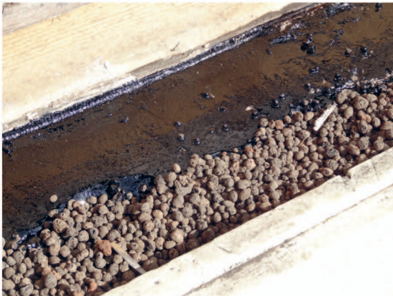
Sokli ja plaadi vahelised tühimikud täideti kergkruusaga.
