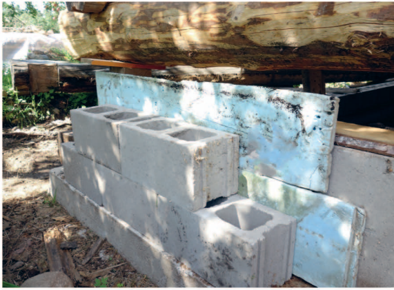
Taldmikule on laotud kaks rida õõnesplokke, mille vahel on soojustusmaterjal.
