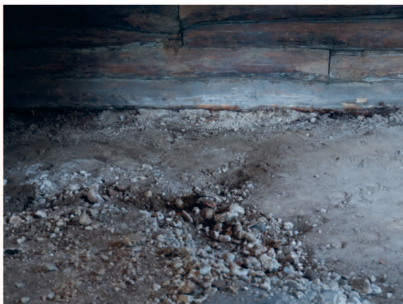
Enne tööde algust: korralik sokliosa puudub ja palgid on praktiliselt vastu pinnast.
