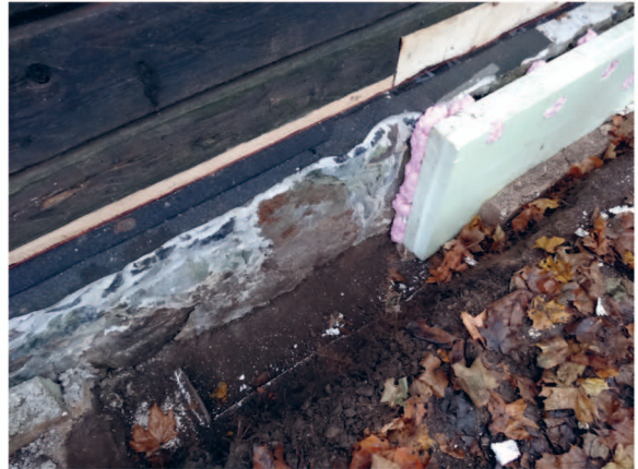
Soklile paigaldatud 10 cm XPS soojustusplaat.
