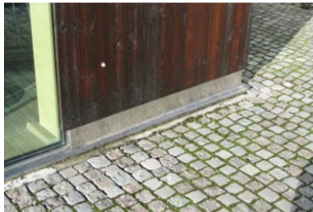
Joonis 7 Maani ulatuv laudvooder on maapinna lähedalt lagunenud ning juba paar aastat pärast ehitamist on tulnud fassaadilauad vahetada ja soklile uus lahendus leida.
