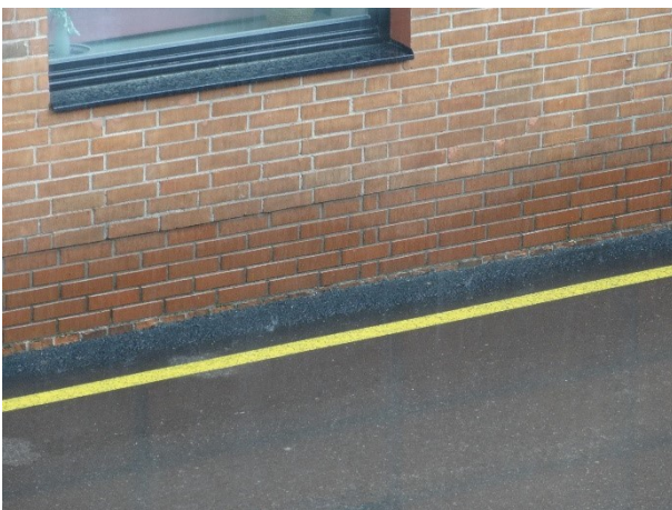
Joonis 5 Mälestise restaureerimisel on kasutatud algset ehituslahendust, mis on juba paar aastat pärast restaureerimist uuesti lagunenud.
