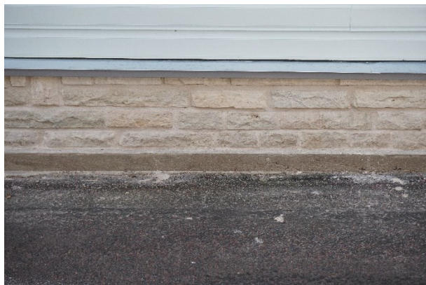
Joonis 7. Rekonstrueeritud paekivisokkel (vasakul, vaata algolukord Joonis 6). Renoveeritud hoone paekivist ja klinkertellistest krohvimata sokkel (paremal).
