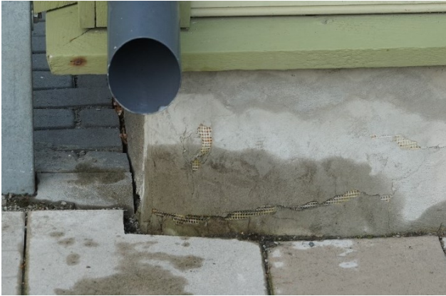
Joonis 6 Lagunenud õhekrohvisüsteemid hiljuti renoveeritud soklil vihmaveetoru läheduses. Vasakul ei ole armeeringu peale paigaldatud sobivat viimistluskrohvi. Paremalt on tegemist küll soklisse sobiliku tootega, kuid vihmaveesülitist liigub vesi pidevalt sokli vastu. Kummalgi juhul ei ole tehtud korrektset 5 cm kõrgusele ulatuvat hüdroisolatsiooni.
