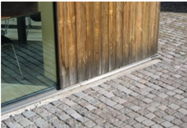
Joonis 7 Maani ulatuv laudvooder on maapinna lähedalt lagunenud ning juba paar aastat pärast ehitamist on tulnud fassaadilauad vahetada ja soklile uus lahendus leida.
