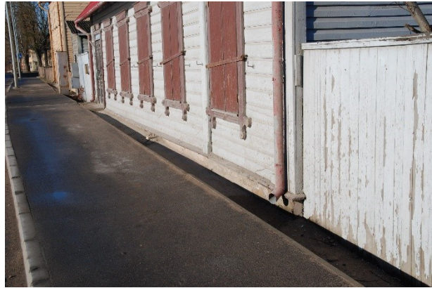
Joonis 4 Tänavarekonstrueerimise tõttu tõusnud maapind, sein on uppunud maa sisse.
