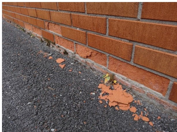
Joonis 5 Mälestise restaureerimisel on kasutatud algset ehituslahendust, mis on juba paar aastat pärast restaureerimist uuesti lagunenud.
