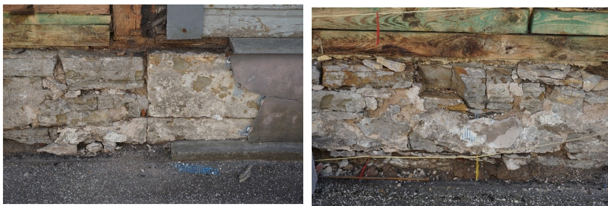
Joonis 6 Kiiresti lagunenud paekvisoklid, mis olid krohvitud armeeritud tsementkrohviga. Tugeva tsementkrohvi kasutamise tagajärjel tuli eemaldada lisaks kogu krohvile ka lagunenud paekivimüüritist.
