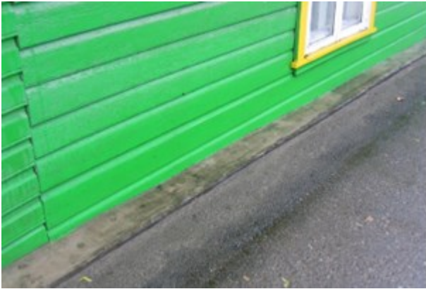
Joonis 4 Tänavarekonstrueerimise tõttu tõusnud maapind, sein on uppunud maa sisse.
