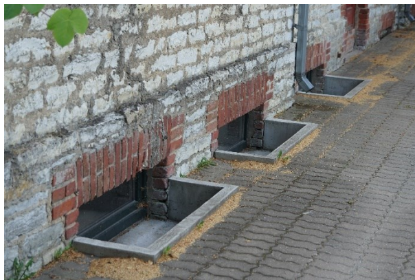
Joonis 7. Rekonstrueeritud paekivisokkel (vasakul, vaata algolukord Joonis 6). Renoveeritud hoone paekivist ja klinkertellistest krohvimata sokkel (paremal).
