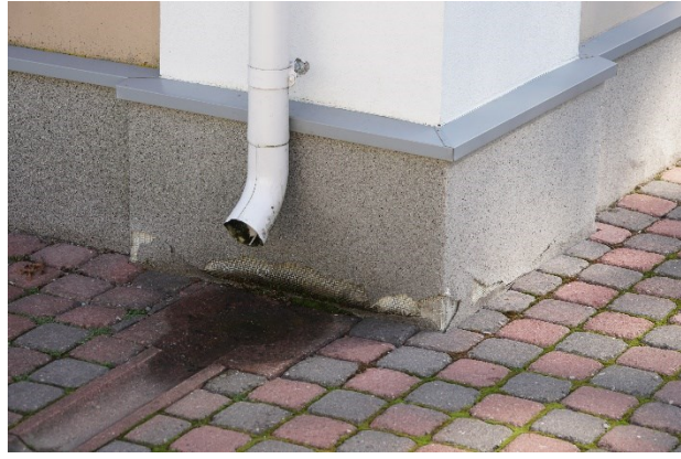
Joonis 6 Lagunenud õhekrohvisüsteemid hiljuti renoveeritud soklil vihmaveetoru läheduses. Vasakul ei ole armeeringu peale paigaldatud sobivat viimistluskrohvi. Paremalt on tegemist küll soklisse sobiliku tootega, kuid vihmaveesülitist liigub vesi pidevalt sokli vastu. Kummalgi juhul ei ole tehtud korrektset 5 cm kõrgusele ulatuvat hüdroisolatsiooni.
