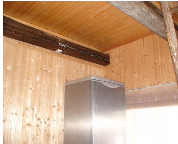
Joonis 2.31 Vana palkseina (vasakul) ja laudvoodri (paremal) eksponeerimine.
