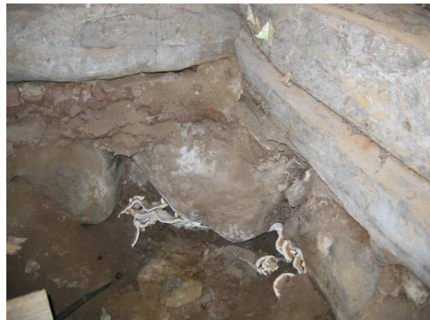
Joonis 4.8 Vetikatega kaetud esimese rea seinapalk (vasakul). Torikseen vundamendi all (paremal).
