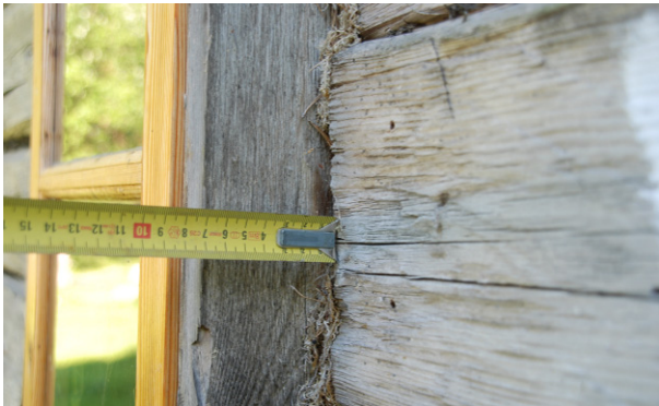
Joonis 9.3 Välisseinte lisasojustamisel tuleb hoolikalt lahendada liitumised akna ja sokli juures. Üldjuhul võimaldab olemasolev tarindus vanemate palkelamute lisasojustamist ilma hoone väärtust kahjustamata.
