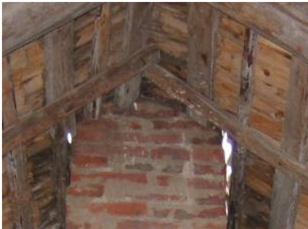
Joonis 2.27 Vasakul mädanikkahjustused korstna ümber. Paremal spetsiaalselt kaldu laotud korsten, et läbiviik katusest jääks harja peale, kus veeprobleemid on minimaalsed.
