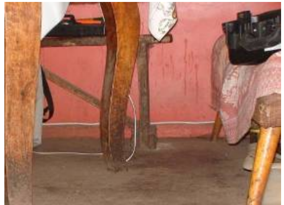
Joonis6.4 Oluline külmasild ( f_{RSi}=0,20 ) põranda ja välisseina liitekohas, kus betoonpõrand on valatud vastu vundamenti. Vasakul termopilt normaalrõhu juures, paremal on näha samast kohast tehtud foto.
