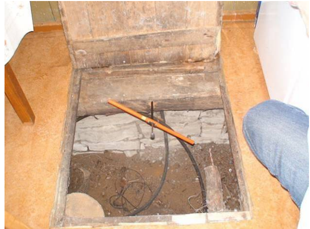
Joonis 2.1 Puiduproovide võtmine seinast (vasakul) ja põrandast (paremal) võimaliku mädanikkahjustuse ja selle ulatuse väljaselgitamiseks.
