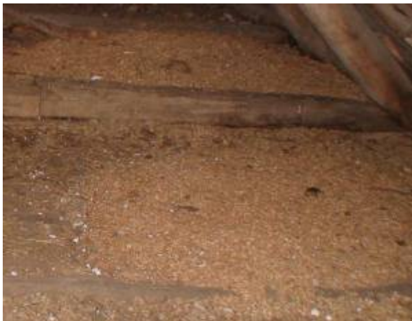
Joonis 2.29 Lae saepurusoojustus (varem olid seal ka heinad, vasakul). Mullaga soojustatud lagi, mis on pinnalt mädanenud (vasakul).
