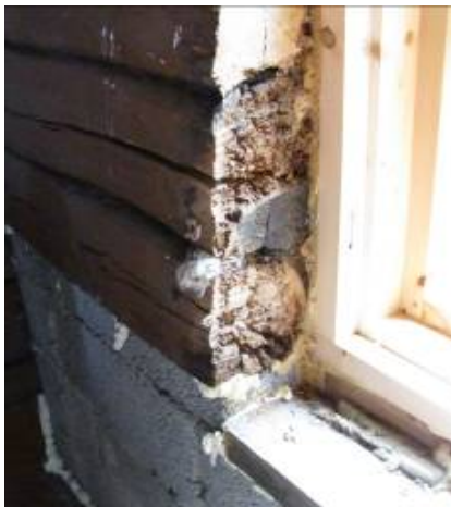
Joonis 2.13 Vasakul mädanenud palgid akna kõrval (alumised palgid vahetatud keramsiitplokkide vastu), paremal pehkinud esimese rea palk.
