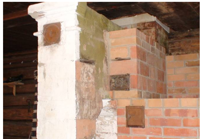
Joonis 2.32 Puitpinna ja ahju vahele ei ole tehtud piisavat mittepõlevast materjalist vahekihti.
