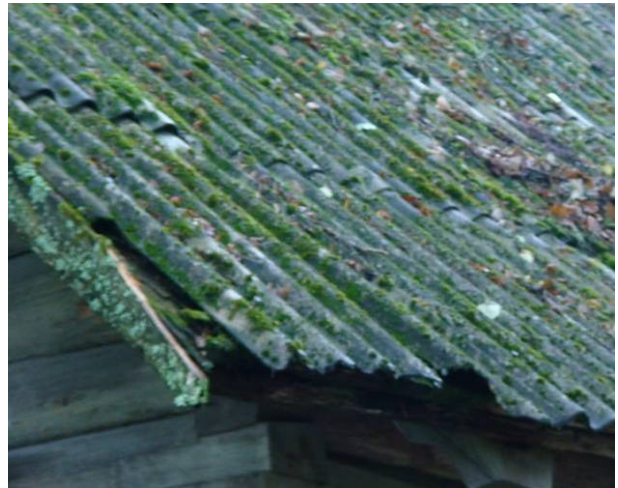
Joonis 2.15 Puude all oleva elamu niiskunud otsasein (vasakul) ja sama elamu sammaldunud katus koos pehkinud otsalauaga (paremal).
