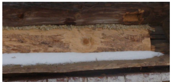
Joonis 2.8 Vasakul niiskunud põrandatalad, paremal proteesitud esimese rea palk (lumi on vastu palki).
