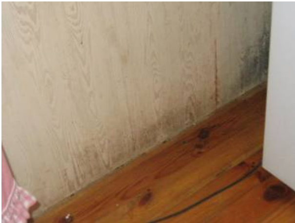
Joonis 2.17 Hallitus seina sisepinnal.
