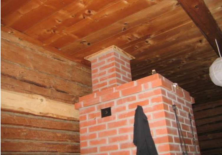
Joonis 2.33 Korstna ümber ja ahju taga on betoonist krae.
