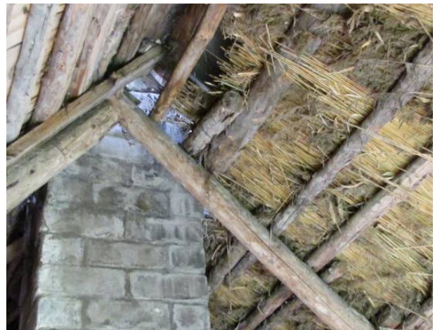
Joonis 2.34 Tuleohtlik olukord põõningul: heinad on korstna lähedal (vasakul) ja katussarikad on vastu korstnat (paremal).
