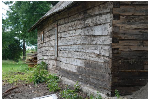
Joonis 2.3 Laialivajunud vundament (vasakul). Vundamendi vajumisest tingitud seinapalkide kõverdumine (paremal).
