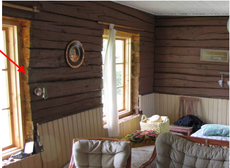
Joonis 9.8 Tenderpostideks olnud aknaraamide eemaldamisse korral tuleb tagada tugi palgiotstele.
