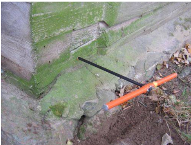
Joonis 4.8 Vetikatega kaetud esimese rea seinapalk (vasakul). Torikseen vundamendi all (paremal).
