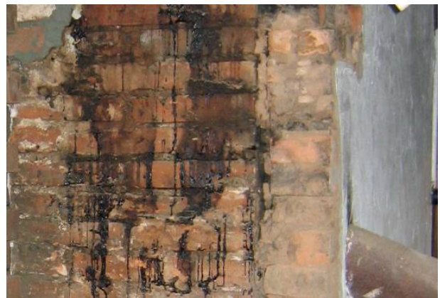
Joonis 2.35 Korstnakivide vahelised vuugid ei ole tihedad (vasakul). Läbi korstna on tunginud pigi (paremal).
