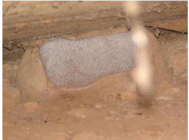
Joonis 2.7 Ummistunud tuulutusava (vasakul). Jäätunud veeauru kondensaad põranda all vundamendi lähedal (paremal).
