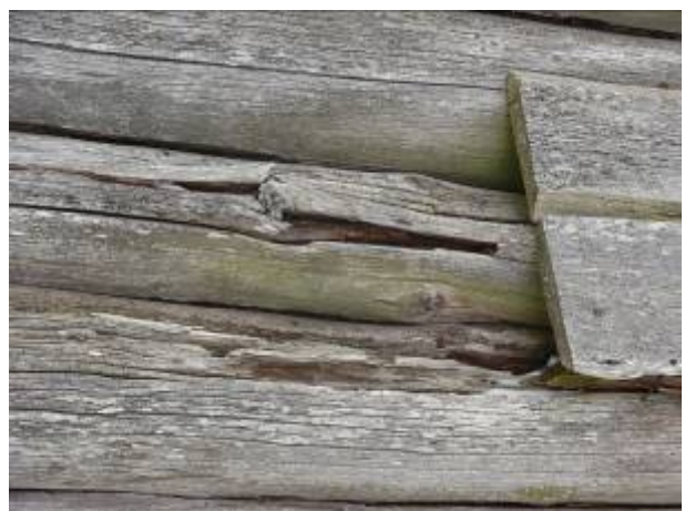
Joonis 2.16 Mädanikkahjustustega palgid. Parempoolsel pildil on mädanenud koht kaetud laudadega, mis omakorda kiirendab mädanemist, kuna kuivamine toimub aeglasemalt.
