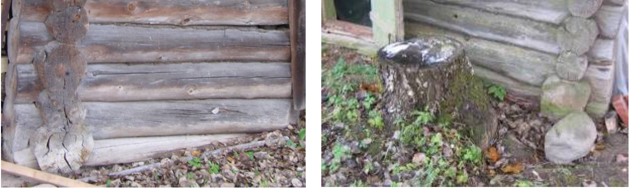
Joonis 2.12 Pooleldi pinnasesse vajunud ja mädanenud esimene palk, neljanda palgirea kohale tekkinud pragu, paremal vajunud uks. Näha on aastaid koristamata lehesodi.
