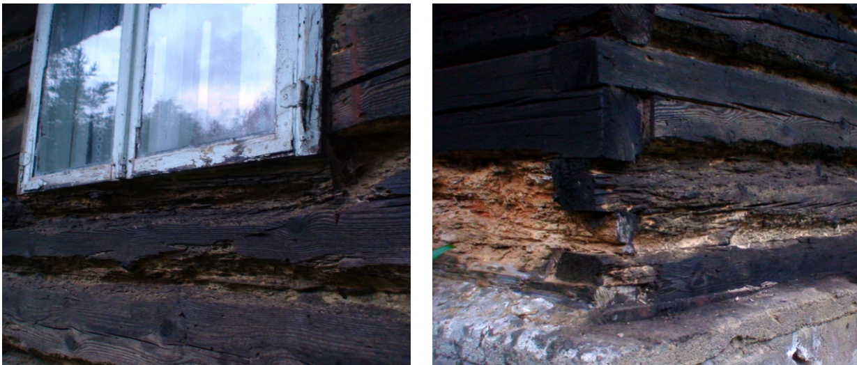
Joonis 2.20 Mädanikkahjustus aknalaua all (vasakul) ja mädanikkahjustused esimestes palgiredades (paremal).
