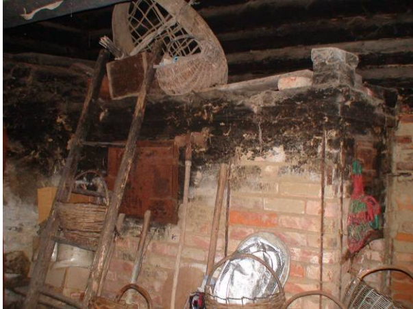
Joonis 2.36 Potentsiaalne oht tulekahju tekkeks on küttekeha peale ja ümber kuhjatud asjad (vasakul). Puitpõrand tuleb kaitsta võimalike sädemete eest metall- või betoonplaadiga ahjusuu ees.
