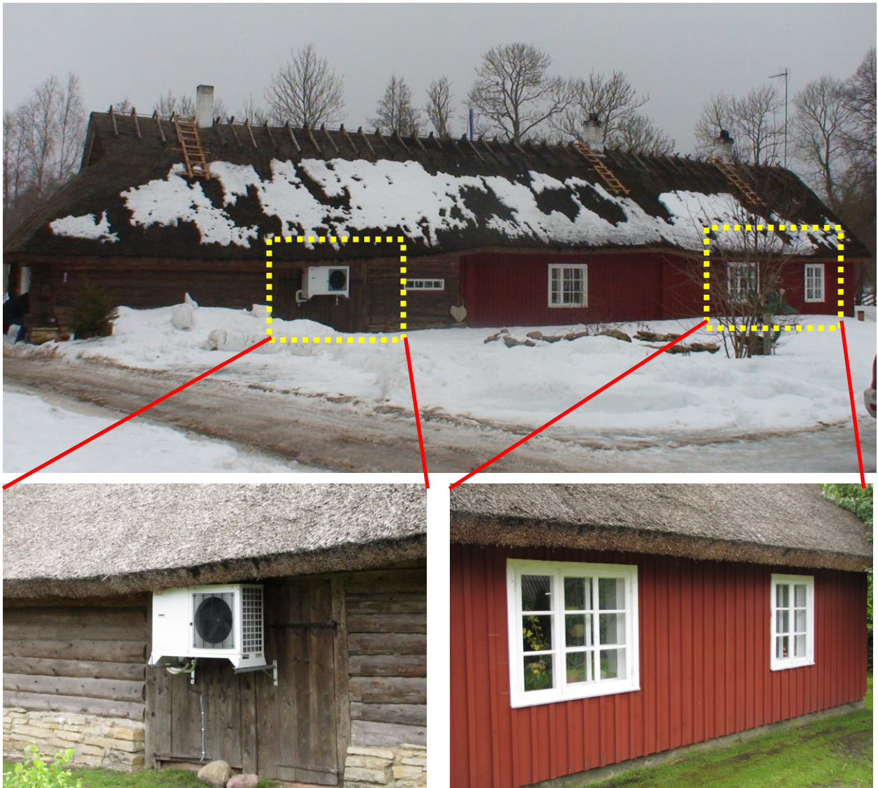
Joonis 8.14 Elamu energiatõhusust on võimalik parandada nii tehnosüsteemide (all vasakul) kui ka hoonepiirete soojustamisega (all paremal). Tähtis on, et hoone arhitektuurne väärtus säiliks.
