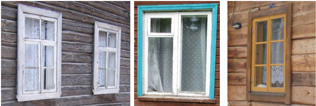
Joonis 2.30 Vanad levinuimad aknad: kuue ruuduga (vasakul) ja kahe ruuduga ning õhuaknaga (keskel). Uus puitraamides aken (paremal).
