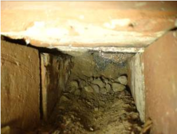
Joonis 2.7 Ummistunud tuulutusava (vasakul). Jäätunud veeauru kondensaad põranda all vundamendi lähedal (paremal).
