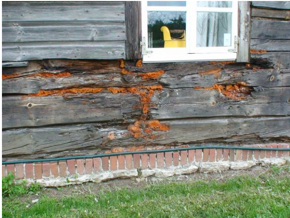
Joonis 2.21 Tugevate mädanikkahjustustega välissein (vasakul) ja kahjustatud alumise poolega esimese palgi sisekülg (paremal).
