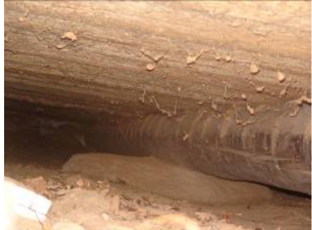
Joonis 2.6 Vundamendis olev spetsiaalne tuulutusaug (vasakul). Alt tuulutatav põrand (paremal; põrandatala toetub suurele maakivile).
