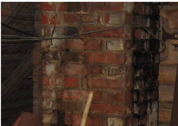
Joonis 2.35 Korstnakivide vahelised vuugid ei ole tihedad (vasakul). Läbi korstna on tunginud pigi (paremal).
