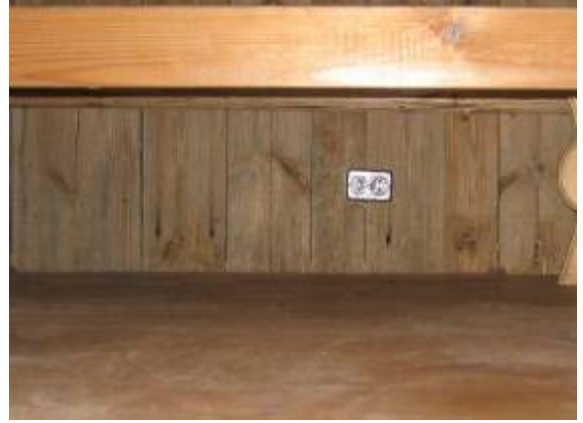
Joonis 6.3 Oluline külmasild ( f_{RSi}=0,4 ) põranda ja välisseina liitekohas: vasakul termopilt normaalrõhu juures, paremal on näha samast kohast tehtud foto.
