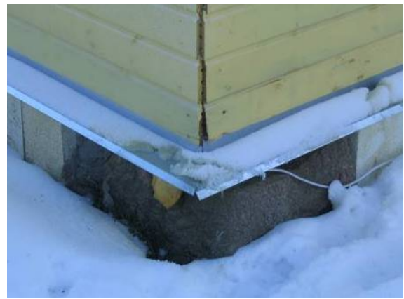
Joonis 6.6 Kohalik külmasild vundamendi nurgas. Vasakul termopilt väljast ja paremal samast kohast tehtud foto.
