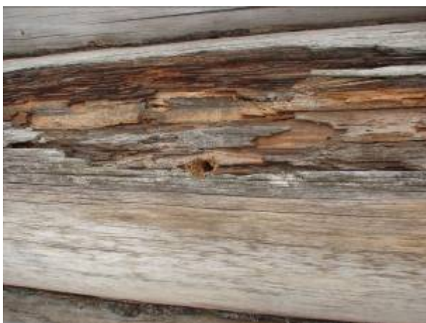
Joonis 2.16 Mädanikkahjustustega palgid. Parempoolsel pildil on mädanenud koht kaetud laudadega, mis omakorda kiirendab mädanemist, kuna kuivamine toimub aeglasemalt.
