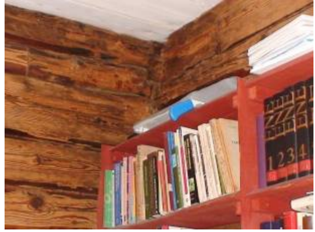
Joonis 2.18 Vasakul kahjustatud laepalk, paremal kahjustatud seinanurk, mis on renoveerimise käigus puhastatud, kuid jäetud katmata, et vajadusel oleks lihtne edasisi kahjustusi avastada ja tõrjuda.
