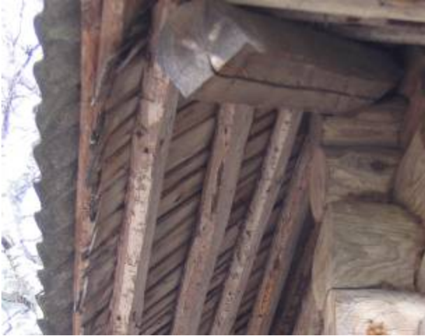
Joonis 2.26 Laastukatus on kaetud eterniidiga (vasakul). Eterniitkatuse ajutine paikamine ei pruugi tagada veepidavust (paremal).
