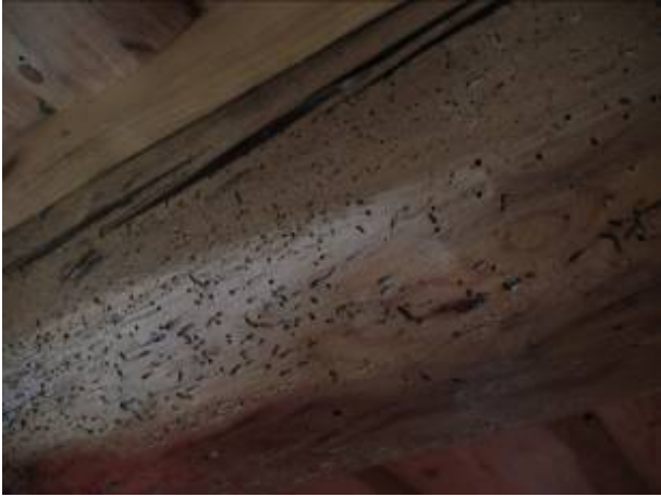
Joonis 2.18 Vasakul kahjustatud laepalk, paremal kahjustatud seinanurk, mis on renoveerimise käigus puhastatud, kuid jäetud katmata, et vajadusel oleks lihtne edasisi kahjustusi avastada ja tõrjuda.
