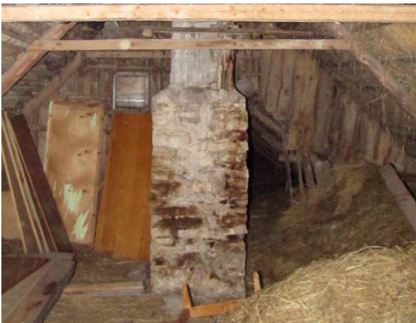
Joonis 2.34 Tuleohtlik olukord põõningul: heinad on korstna lähedal (vasakul) ja katussarikad on vastu korstnat (paremal).
