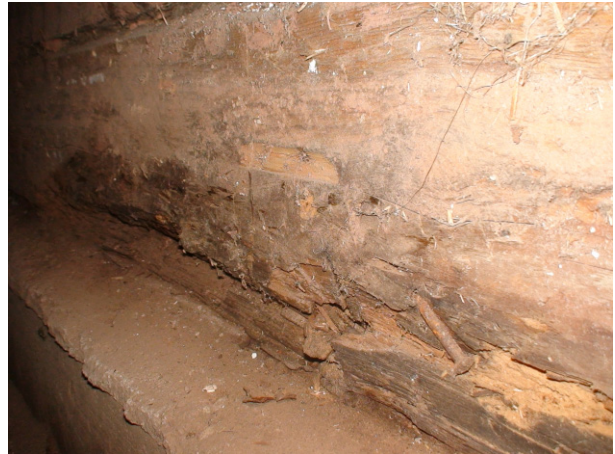
Joonis 2.21 Tugevate mädanikkahjustustega välissein (vasakul) ja kahjustatud alumise poolega esimese palgi sisekülg (paremal).
