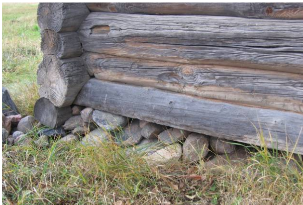
Joonis 2.3 Laialivajunud vundament (vasakul). Vundamendi vajumisest tingitud seinapalkide kõverdumine (paremal).
