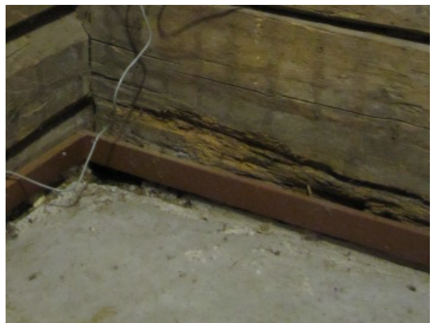
Joonis 2.22 Pragunenud kivisein ahju kõrval (vasakul). Mädanikkahjustusega palkvaheseina alumine palk (paremal).
