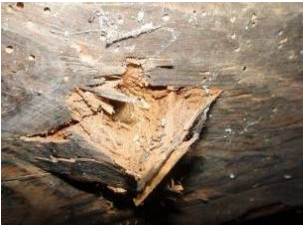
Joonis 2.5 Mädanik- ja mardikakahjustusega põrandatala (vasakul). Kelder, mille põrandal oli vesi (paremal).
