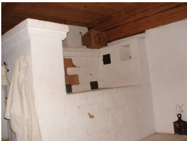
Joonis 2.32 Puitpinna ja ahju vahele ei ole tehtud piisavat mittepõlevast materjalist vahekihti.
