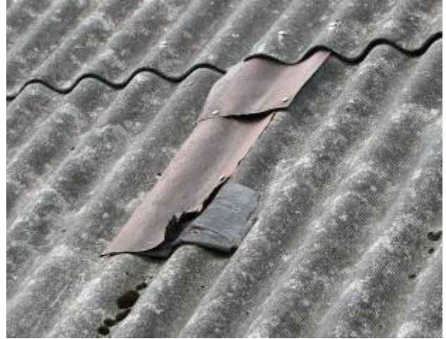
Joonis 2.26 Laastukatus on kaetud eterniidiga (vasakul). Eterniitkatuse ajutine paikamine ei pruugi tagada veepidavust (paremal).
