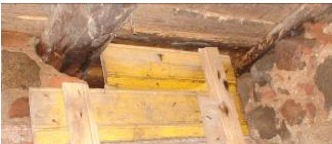
Joonis 2.8 Vasakul niiskunud põrandatalad, paremal proteesitud esimese rea palk (lumi on vastu palki).
