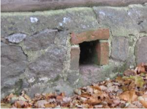
Joonis 2.6 Vundamendis olev spetsiaalne tuulutusaug (vasakul). Alt tuulutatav põrand (paremal; põrandatala toetub suurele maakivile).
