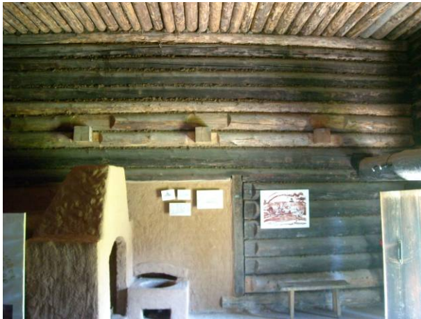
Joonis 2.31 Vana palkseina (vasakul) ja laudvoodri (paremal) eksponeerimine.
