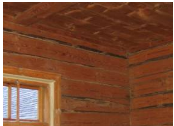
Joonis 7.8 Termopilt 50 Pa alarõhu juures näitab tugevat õhuleket nurgatappide vahelt ja laetala ning sein ühenduskohast, samuti sein ja lae liitekohast.
