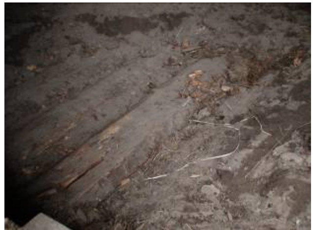
Joonis 2.29 Lae saepurusoojustus (varem olid seal ka heinad, vasakul). Mullaga soojustatud lagi, mis on pinnalt mädanenud (vasakul).
