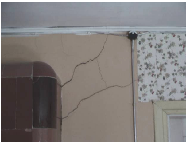
Joonis 2.22 Pragunenud kivisein ahju kõrval (vasakul). Mädanikkahjustusega palkvaheseina alumine palk (paremal).
