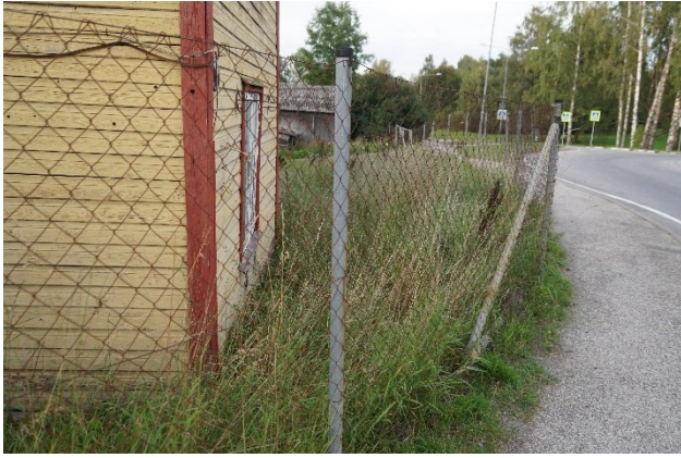
Joonis 3 Kõnnitee kõrgus ületab aknalaua tasapinna kahel hoonel erinevates asumites. Tee mulde järsud kalded hoone poole ning kõnnitee ja hoone vahe on hooldamata.
