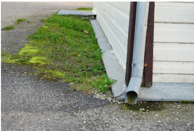
Joonis 3 Vihmaveetoru suunab vee tänava pinnale, kust see jookseb kohe hoone soklisse.
