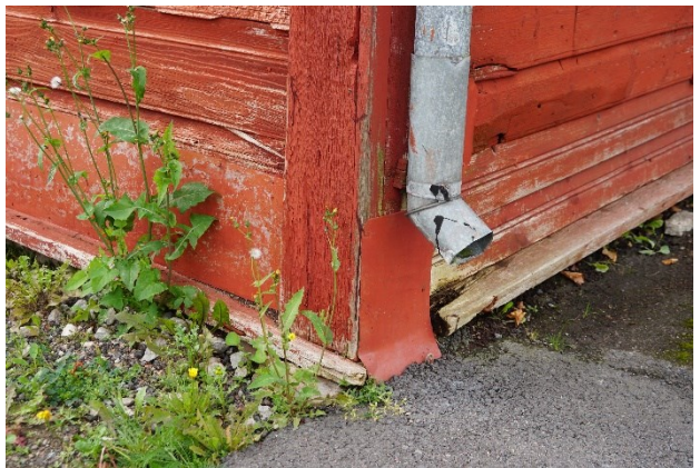
Joonis 3 Vihmaveetoru suunab vee tänava pinnale, kust see jookseb kohe hoone soklisse.
