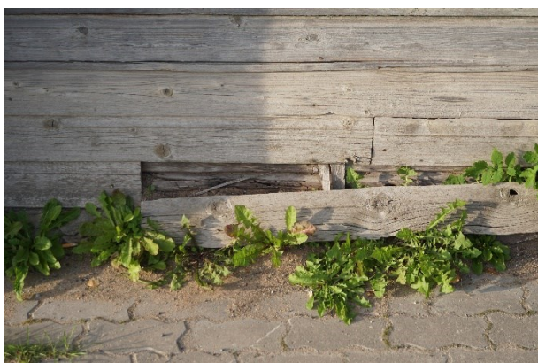
Joonis 2 Detailvaade kahest joonisel 1 toodud maja fassaadilõigust: vasakpoolsel fotol ulatub laudvooder peaaegu vastu kõnnitee sillutist, parempoolsel fotol on sokkel veidi kõrgem, kuid veelaud puudub ning soklikivid on lahti ja tühjade vuukidega.
