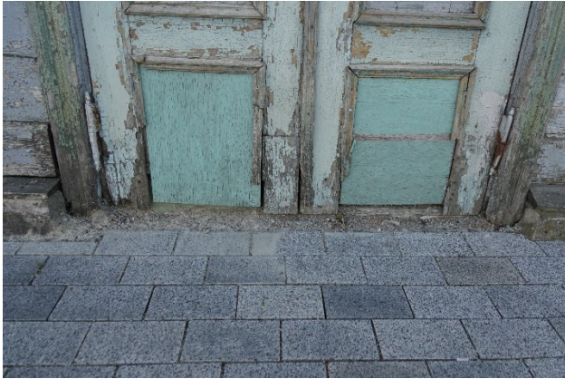
Joonis 4 Vana väärtuslik tänavapoolne tiibuks on uppunud värskelt paigaldatud kõnnitee tasapinna sisse (vasakul). Tänavasillutisse uppunud, plekiga kaetud alaosa väärtuslik uks (paremal).
