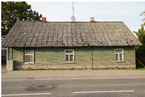
Joonis 1 Hoone sokkel on kuni 10 cm kõrge. Paremalt sama hoone otsasein, millelt on näha, et hoovi pool on sokli kõrgus üle poole meetri.
