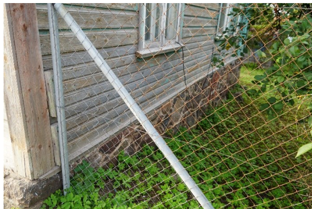
Joonis 1 Hoone sokkel on kuni 10 cm kõrge. Paremalt sama hoone otsasein, millelt on näha, et hoovi pool on sokli kõrgus üle poole meetri.
