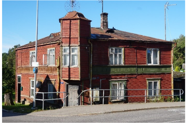
Joonis 3 Kõnnitee kõrgus ületab aknalaua tasapinna kahel hoonel erinevates asumites. Tee mulde järsud kalded hoone poole ning kõnnitee ja hoone vahe on hooldamata.
