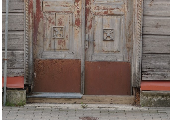
Joonis 4 Vana väärtuslik tänavapoolne tiibuks on uppunud värskelt paigaldatud kõnnitee tasapinna sisse (vasakul). Tänavasillutisse uppunud, plekiga kaetud alaosa väärtuslik uks (paremal).
