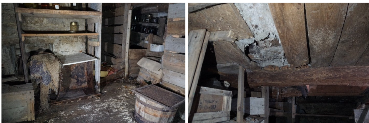
Joonis 4 Tüüpiline kortermaja kelder kartulitele ja hoidistele. Keldripõrand on huumusega kaetud ja määrg ning puitriiulid on mädanikkahjustustega. Omanik elas välismaal ning keldri aken ja sissepääs olid suletud, kelder polnud aktiivses kasutuses. Paremal sama keldri puidust avariiliseks pehkinud vahelae osa (põhjused võisid olla ka esimesel korrusel, kuhu ligi ei saanud).
