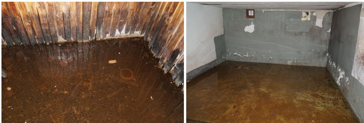
Joonis 5 Keldrisse rajatud pesuruumi vettinud laudis, kuna kortermaja keldri põrandal oli suurem osa aastast 10–20 cm vett (vasakul). Paremal sama maja teine keldriruum, mille põrandal on 10 cm vett, sein on märg ja värv seina alaosast koorub. Seina ülasos on näha kaks ventilatsiooniava.
