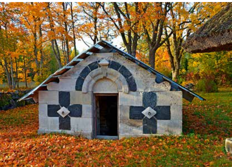
< Leeskopa küla Salu talu rikkaliku kujundusega keldri (1910) restaureeris meister Rein Saksakulm. Keldri esiküljel on raudkiviristide keskel dolomiidist romb, ukse kohal kaheastmeline soonitud servaga ümarkaar ning tugevalt eenduv katusega lukukivi. (Foto: Heiki Pärdi)
