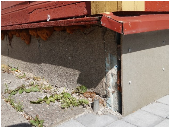
Joonis 3 Hoone otsasein on soojustatud ja tsementkiudplaadiga kaetud ja esikülg on vana krohvitud lahendus (vasakul). Sokli soojustuslahendus on märgatavalt tõusnud (külmakerked?), muutes veepleki kalde tugevalt negatiivseks ja purustades viimistluseks kasutatud tsementkiudplaadi.
