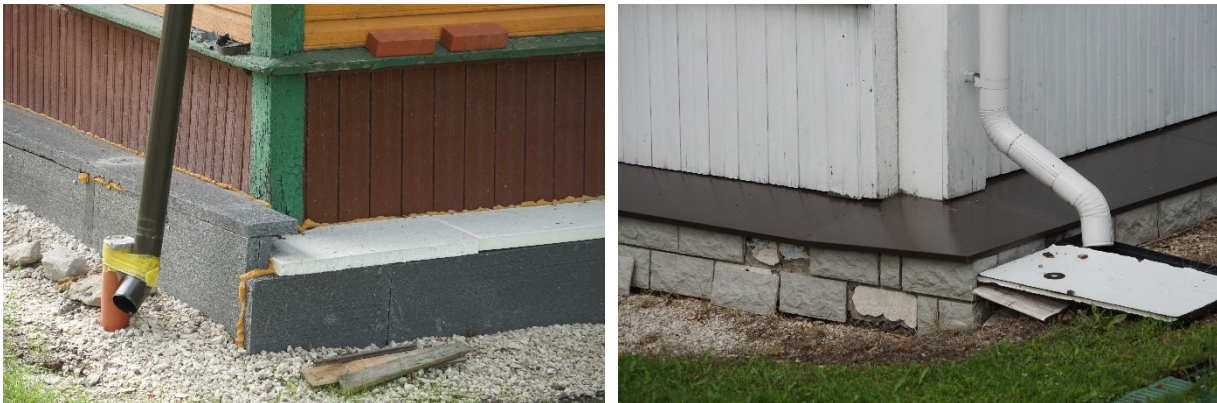
Joonis 5 Vundament on soojustatud puithoonele sobimatult (vasakul). Sokkel on soojustamise tõttu muutunud väga laiaks (üle 30 cm).
