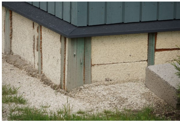
Joonis 4 Elamu sokkel on soojustatud puitkarkassi vahele paigaldatud soojustusega: pritsitud polüuretaanvaht (paremal) ja vahtpolüstüreen (vasakul). Puitpostid on kontaktis niiske pinnasega.
