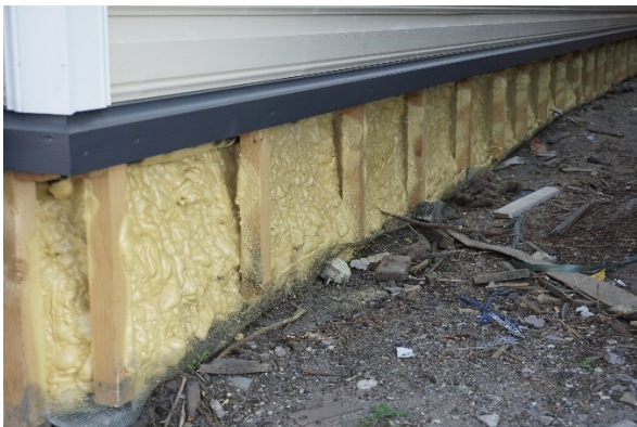
Joonis 4 Elamu sokkel on soojustatud puitkarkassi vahele paigaldatud soojustusega: pritsitud polüuretaanvaht (paremal) ja vahtpolüstüreen (vasakul). Puitpostid on kontaktis niiske pinnasega.
