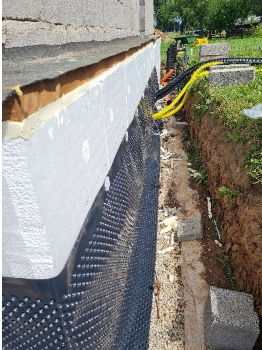
Joonis 8 Sokli soojustus on maapinnast allpool kaetud drenmatiga, mis kaitseb soojustust tagasitäitmisel mehaaniliste kahjustuste eest. Enne sokli soojustamist on paigaldatud fassaadi soojustuse kihi alumine pruss, mille peale hiljem ehitatakse puitkarkass, mille vahed soojustatakse pehme plaatvillaga. Pruss ja sokli soojustus on kaitstud ehitusaegsete sademete eest väljapoole kaldu oleva bituumenribaga.
