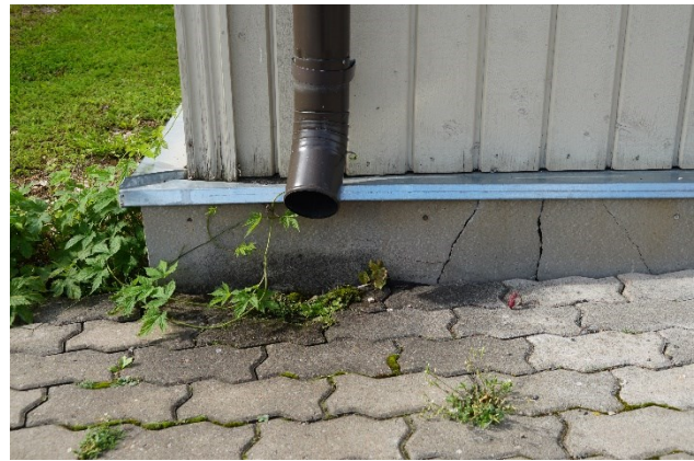
Joonis 3 Hoone otsasein on soojustatud ja tsementkiudplaadiga kaetud ja esikülg on vana krohvitud lahendus (vasakul). Sokli soojustuslahendus on märgatavalt tõusnud (külmakerked?), muutes veepleki kalde tugevalt negatiivseks ja purustades viimistluseks kasutatud tsementkiudplaadi.
