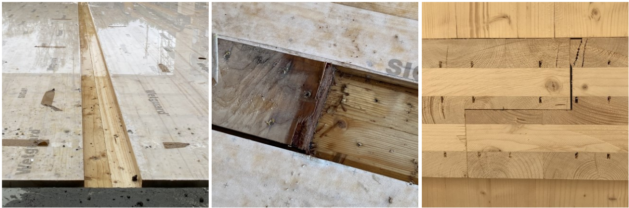
Joonis 9 Sademete eest kaitsmisel on oluline liitekohtade geomeetria. Vältida tuleb nõgususi ja süvendeid, kuhu vesi saab koguneda (vasakul). Eriti halb on, kui tekivad niiskust lukustavad liitekohad ehk märjale liitekohale paigaldatakse väljakuivamist takistav kiht, nt vineer (keskel). Selline liitekoht võib kiirelt kahjustuda (sh mädanikseente tõttu). Parem on projekteerida liitekohad selliselt, et nõgususi ei teki (paremal). Fotod: Kristo Kalbe.
