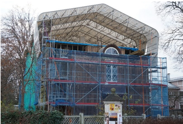
Joonis 23 Telk katusevahetuse perioodiks vana puitelamu kohal (vasakul). Koormakate säilitatavate sarikate peal katusekatte vahetuse töötsoonis (paremal). Fotod: Üllar Alev.
