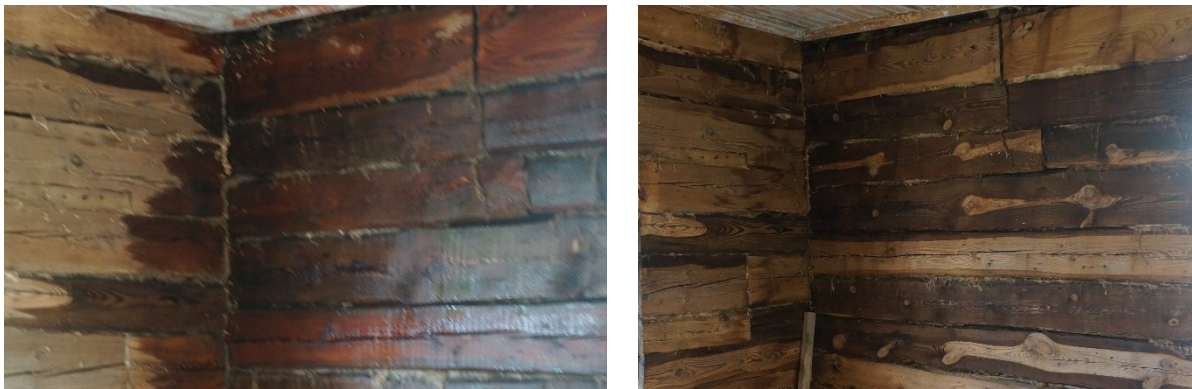
Joonis 19 Vettinud palksein (vasakul) ja sama sein 45 päeva hiljem (paremal), sama maja otsasein seest, mis Joonis 14. Fotod: Üllar Alev.
