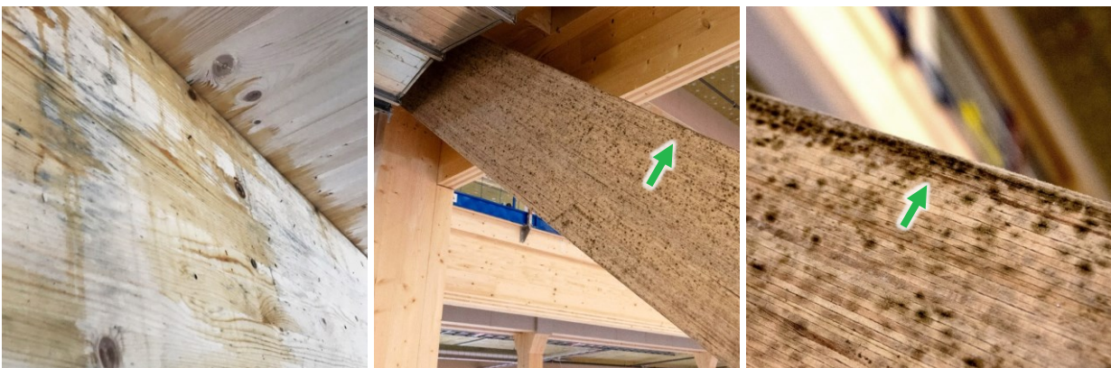
Joonis 17 Ehituse ajal sademete eest kaitsmata paigaldatud (vasakul) või puuduliku ilmastikukaitsega ladustatud (keskel ja vasakul) puitmaterjalil võib mikroobide kasv alata juba ehituse faasis. Fotod: Kristo Kalbe.
