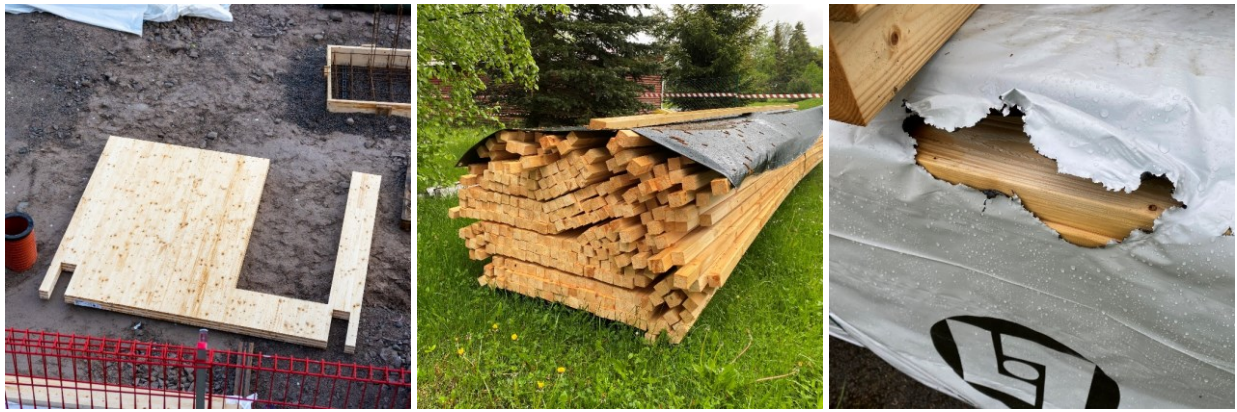
Joonis 1 Niiskustundlikke materjale ei tohi ladustada pinnasega kontaktis ega sademetele avatult (vasakul ja keskel). Pakkekile ei ole tavaliselt ilmastikukaitseks piisav (paremal). Parema lahenduse on ladustada materjale ajutise katuse all. Fotod: Kristo Kalbe.
