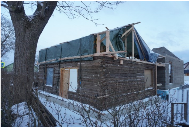
Joonis 24 Palkhoone kohale on ehitatud ajutine viilkatus koormakattega, ent katte üleulatus seinast puudub.
