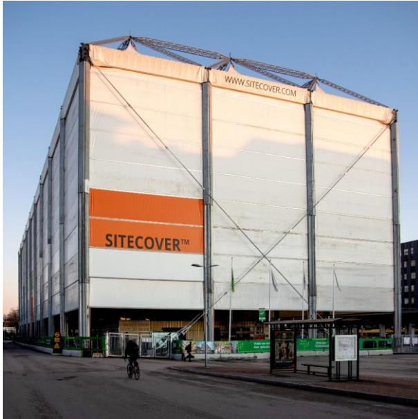
Joonis 21 Näited täielikust ilmastikukaitsest ehk kogu hoonet katvatest ilmastikukaitselahendustest. Vasakpoolsel fotol toimus kogu ehitus katte all, sh ristkihtliimpuitpaneelide montaaž. Sildkraana kuulus ilmastikukatte koosseisu. Parempoolsel fotol püstitati ilmastikukaitse tellingud ja ajutine katus pärast kandetarindite püstitust ning seega olid vajalikud ka aktiivne niiskushohe ja lokaalsed võtted ehituse kaitsmisel sademete eest. Fotod: Kristo Kalbe.
