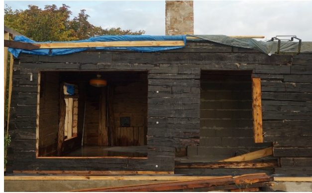
Joonis 14 Katusekonstruktsioonide montaaž ja paigaldus kaldeta koormakatte peal on vihmastel päevadel halb lahendus (vasakul). Lisaks tuleb tagada ajutise katte üleulatus seinast, et vihmavesi koormakattelt seinale ei valguks (paremal puudulik lahendus).
