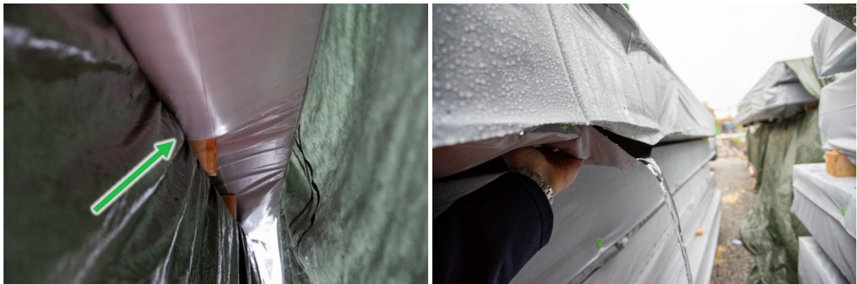
Joonis 2 Pakkekile ja koormakatte kombinatsioon ei taga kaitset sademete eest. Ehitusplatsil ladustatud materjalide pakenditesse võib koguneda vesi (vasakul). Vajalik on pidevalt kontrollida ilmastikukaitse toimivust, sh avades/lõigates katteid, kui ilmastikukaitse on osutunud ebaõnnestunuks (paremal). Parema lahenduse on ladustada materjale ajutise katuse all. Fotod: Kristo Kalbe.
