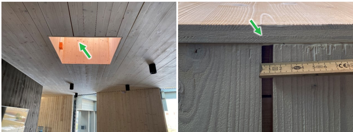
Joonis 16 Ehitusaegne liigne märgumine põhjustab ristkihtliimpuitpaneeli tavapärasest oluliselt ulatuslikumat lõhenemist/pragunemist. Nooled fotodel osutavad samadesse kohtadesse (vasakul üldvaade, paremal lähivaade). Sama hoone, millest fotod Joonis 11. Fotod: Kristo Kalbe.
