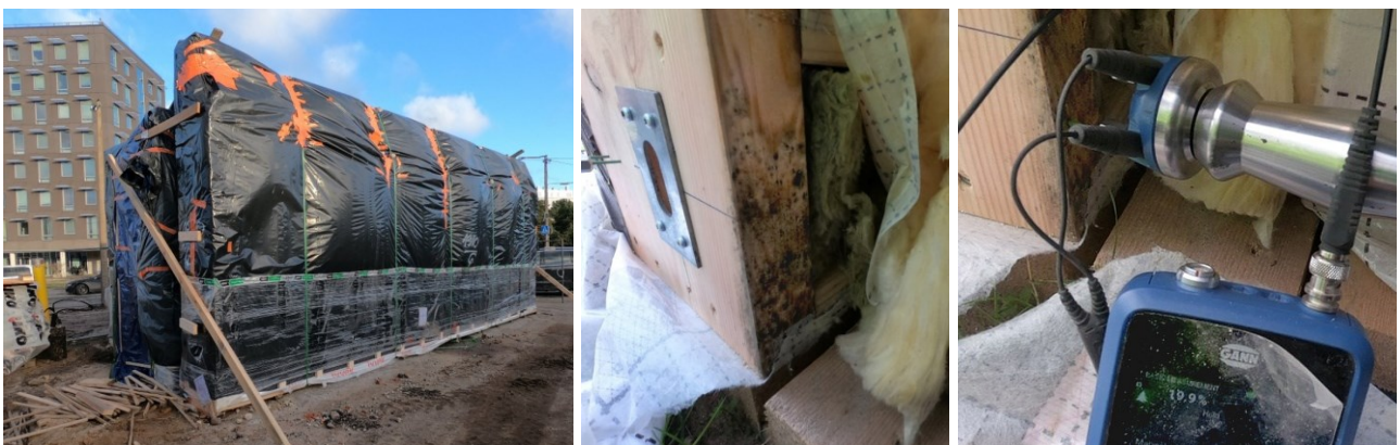
Joonis 3 Pakkekile ei ole sobiv materjal lisasoojustuspaneelide ilmastikukaitseks ladustamisel (vasakul). Selliselt ladustamise tulemusena algas hallituse kasv karkassipostidel (keskel). Kontrollimiseks avamise ajal oli puidu niiskussisaldus 20% (paremal). Parema on tarnida lisasoojustuspaneelid vahetult enne montaaži või ladustada ajutise katuse all.
