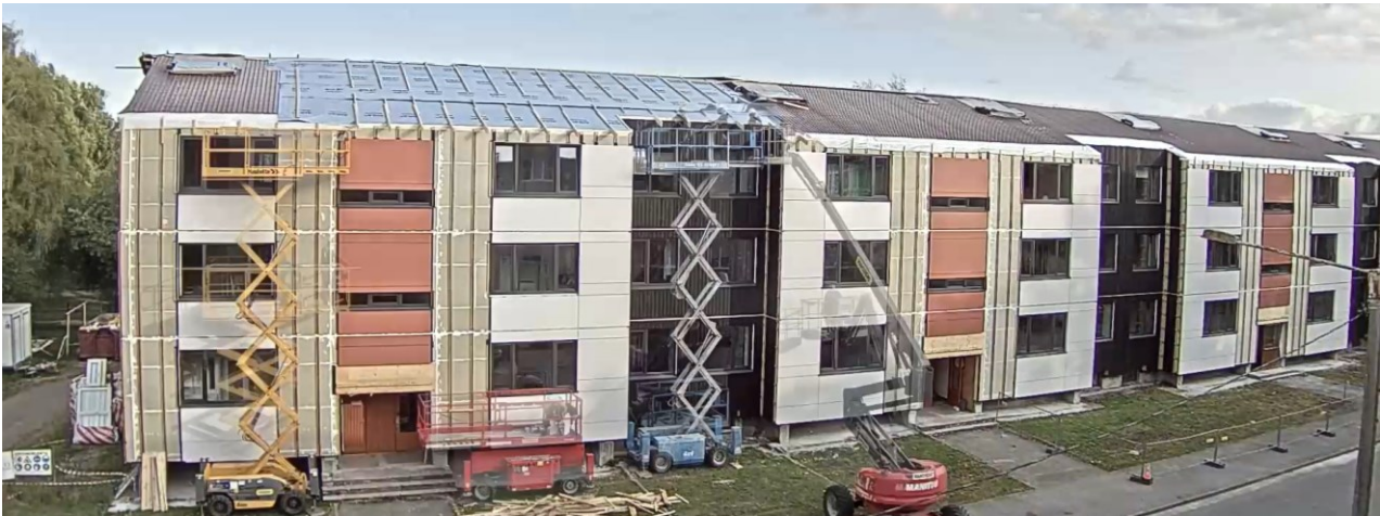
Joonis 22 Näide renoveeritava korterelamu katuse järkjärgulisest vahetusest. Iga päev avati ainult väike osa katusest, et päeva lõpuks saaks sama osa uue katuse aluskatte ja pööning oleks sademete eest kaitstud. Samal ajal toimus ka lisasoojustuspaneelide paigaldus. Foto: Kristo Kalbe.
