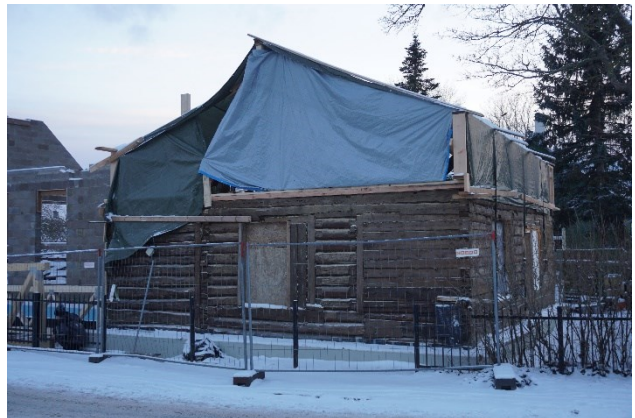
Joonis 24 Palkhoone kohale on ehitatud ajutine viilkatus koormakattega, ent katte üleulatus seinast puudub.
