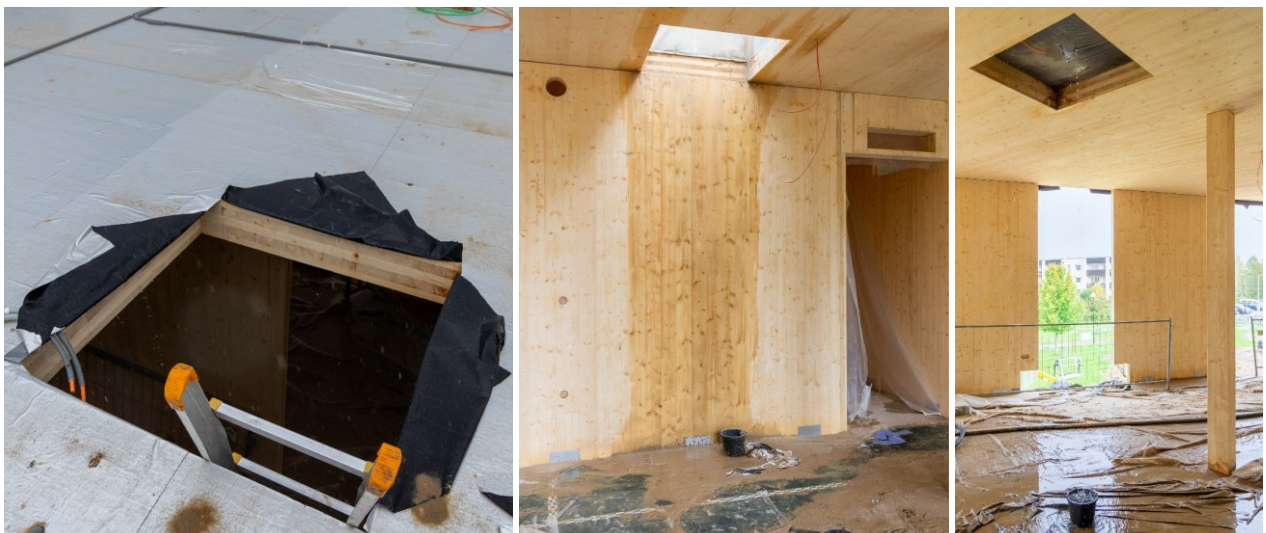
Joonis 10 Ilma kogu hoonet katva eraldiseisva ajutise ilmastikukaitseta ehitamisel on vajalik kohe hermetiseerida veekindlalt kõik läbiviigud. Korrektselt tihendamata läbiviigud (vasakul, paremal) põhjustavad veelekkeid (keskel) läbi muidu ilmastikukindla katuse. Majapidamisteip ei ole piisavalt ilmastikukindel ega sobi tarindite ja ajutise ilmastikukaitse läbiviikude tihendamiseks (paremal). Fotod: Kristo Kalbe.
