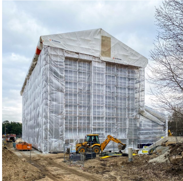
Joonis 21 Näited täielikust ilmastikukaitsest ehk kogu hoonet katvatest ilmastikukaitselahendustest. Vasakpoolsel fotol toimus kogu ehitus katte all, sh ristkihtliimpuitpaneelide montaaž. Sildkraana kuulus ilmastikukatte koosseisu. Parempoolsel fotol püstitati ilmastikukaitse tellingud ja ajutine katus pärast kandetarindite püstitust ning seega olid vajalikud ka aktiivne niiskushohe ja lokaalsed võtted ehituse kaitsmisel sademete eest. Fotod: Kristo Kalbe.
