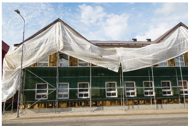
Joonis 25 Tellingute katmine fassaadi ümberehituse ajaks. Foto: Üllar Alev.
