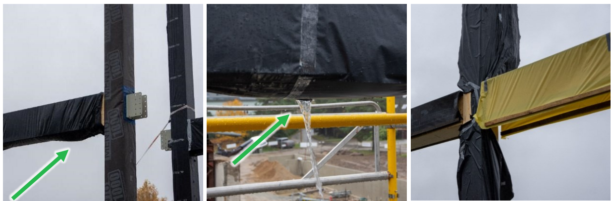
Joonis 6 Ajutine ilmastikukaitse tuleb hästi läbi mõelda. Ilmastikukaitse taha, alla ega sisse ei tohi koguneda sademevesi (vasakul). Oluline on pidevalt kontrollida ilmastikukaitse toimivust, vajaduse korral avades/lõigates katteid, kui ilmastikukaitse on osutunud ebaõnnestunuks (keskel).
