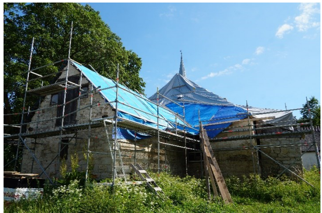
Joonis 23 Telk katusevahetuse perioodiks vana puitelamu kohal (vasakul). Koormakate säilitatavate sarikate peal katusekatte vahetuse töötsoonis (paremal). Fotod: Üllar Alev.
