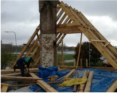
Joonis 14 Katusekonstruktsioonide montaaž ja paigaldus kaldeta koormakatte peal on vihmastel päevadel halb lahendus (vasakul). Lisaks tuleb tagada ajutise katte üleulatus seinast, et vihmavesi koormakattelt seinale ei valguks (paremal puudulik lahendus).
