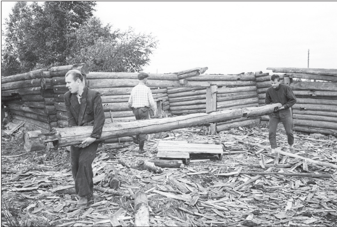
Althärma talu lauda lahtivõtmine Jõeääre külas. Esiplaanil noor ehitusbrigadir Endel Klaus, vasakul on näha nummerdatud plekitükikestega märgistatud seinapalgid. Muuseumis püstitati Althärma laut Sassi-Jaani talu õuele. August 1960. Foto: Fredi Toms. EVM N 68:34.
