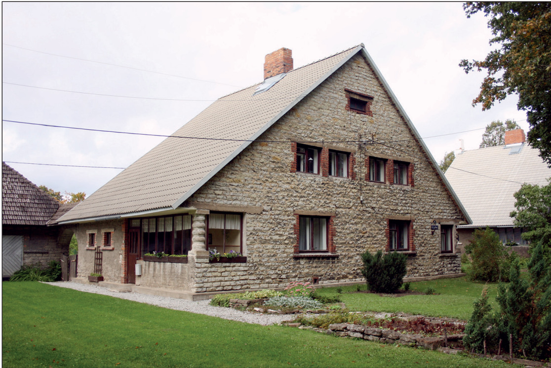
Elamu Kohtla-Järve Siidisuka asumis, Lutsu tn 4. Arhitekt Eugen Habermann. Foto: Heiki Pärdi, 2010.
