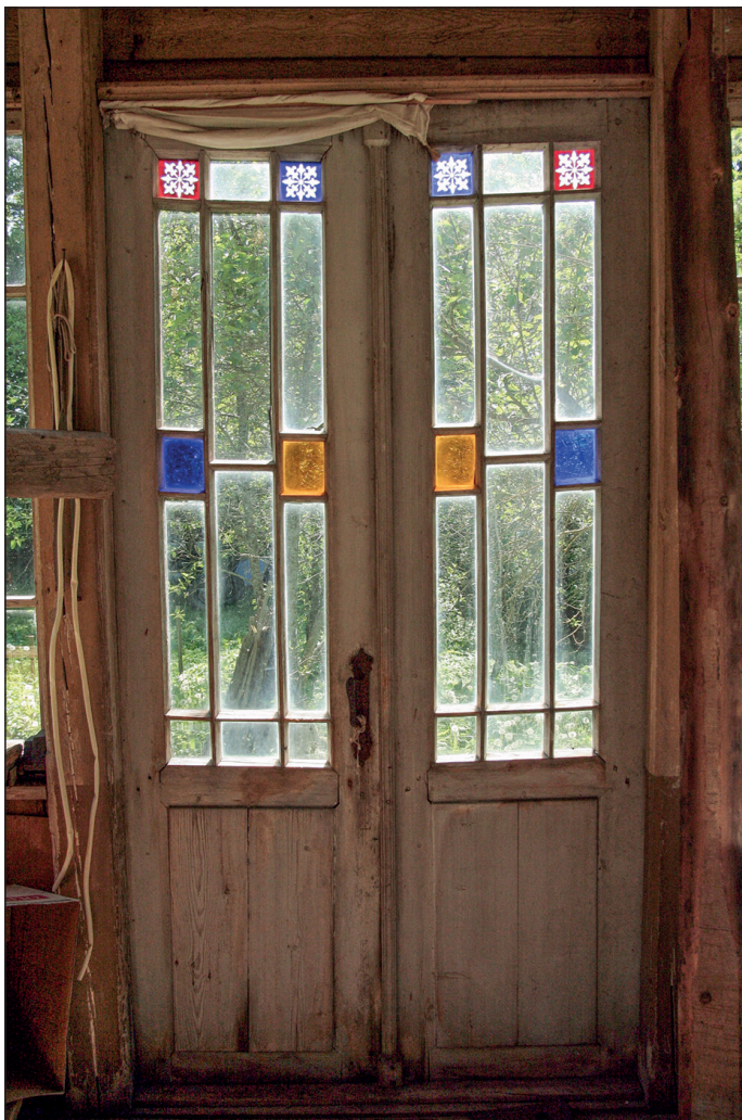
Tagumise veranda uksele on säilinud nii akende algupärane ruudujaotus kui värvilised klaasid. Foto: Heiki Pärdi, 2007.
