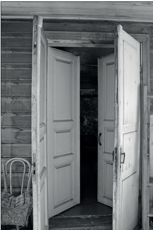
Tagumise veranda ja elutoa vahel on soojapidavuse parandamiseks kahekordsed tiibuksed. Foto: Heiki Pärdi, 2007.
