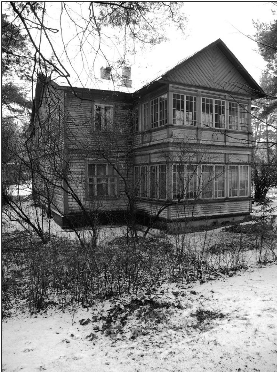
Mõnigi Narva-Jõesuu algselt poolteisekorruselise suvila on hiljem ümber ehitatud kahe täiskorrusega majaks ning kohaldatud korterelamuks. Foto: O. Orro.
