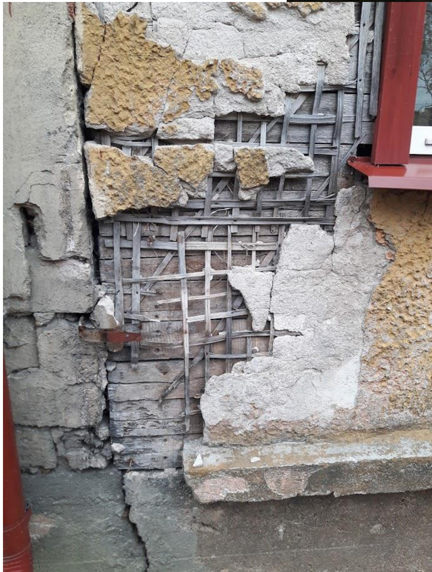
Krohvi hoidmiseks on seinale kinnitatud puitlaastvõrk ja krohvipeergud
