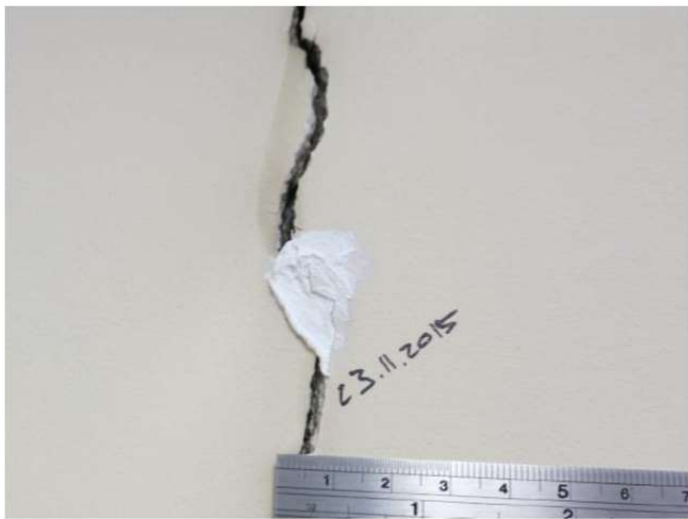
Joonis 12. Kaitseliidu Peastaabi B-korpuse 1. korruse seinale tekkinud pragu, millele paigaldati 23.11.2015. aastal kipsmajakas. Foto on tehtud 16.03.2016. aasta toimunud paikvaatlusel. Kipsmajakas on purunenud. (Kase 2016)
