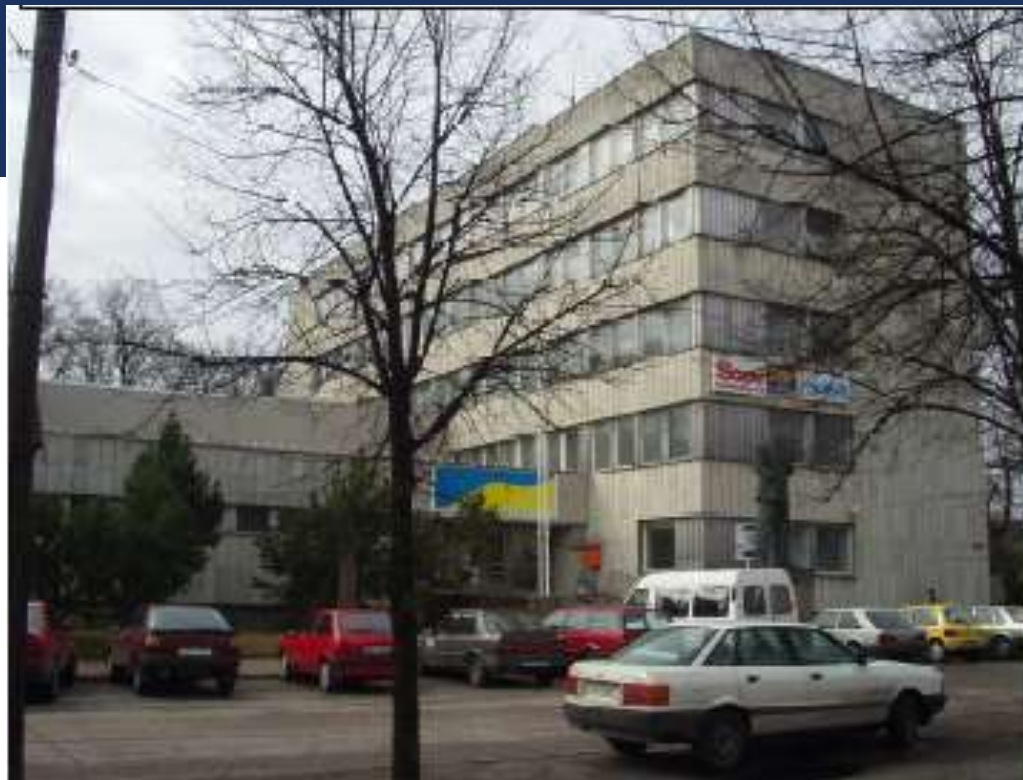
Joonis 3.22 Esplanaadi 10 Pärnus. Keskmine vajum 620 mm, vajumite erim 111 mm.
