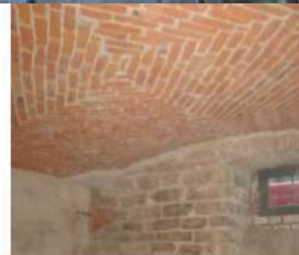
Foto 5. Tellistest laotud vahelagi enne varingut. Foto H.Kuningas
