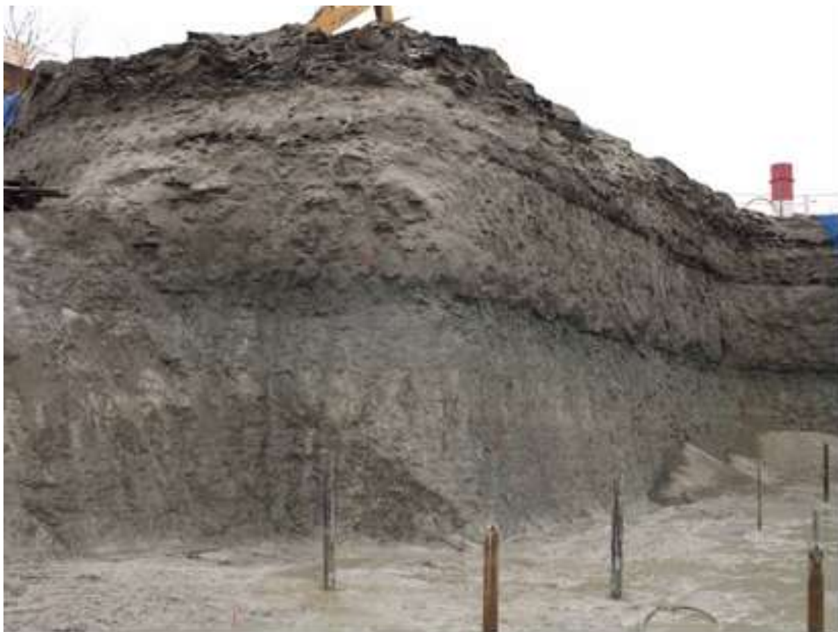
Ligilähedaselt vertikaalsele kaevatud 9 m sügavuse süvendi sein (IPT töö nr.18-08-1439)
