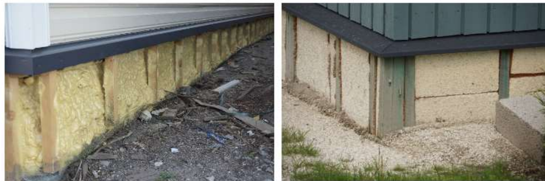
Joonis 4 Elamu sokkel on soojustatud puitkarkassi vahele paigaldatud soojustusega: pritsitud polüuretaanvaht (paremal) ja vahtpolüstüreen (vasakul). Puitpostid on kontaktis niiske pinnasega.
