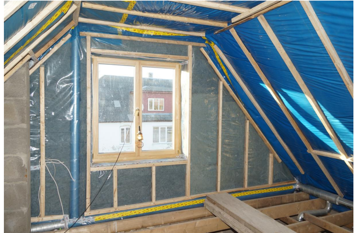
Torud soojustuse sees, aurutõke
