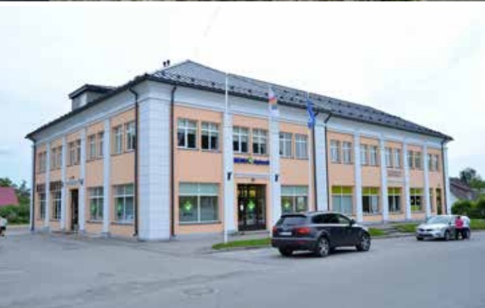
< Alevi südamesse (Hariduse 3) ehitas tollane rajooni tarbijate kooperatiiv 1950. aastate keskpaiku endale stiilse ja soliidse peahoone kontori, kaupluse, kohvik-söökla ja restoraniga. (Foto: H. Pärdi, 2017)
