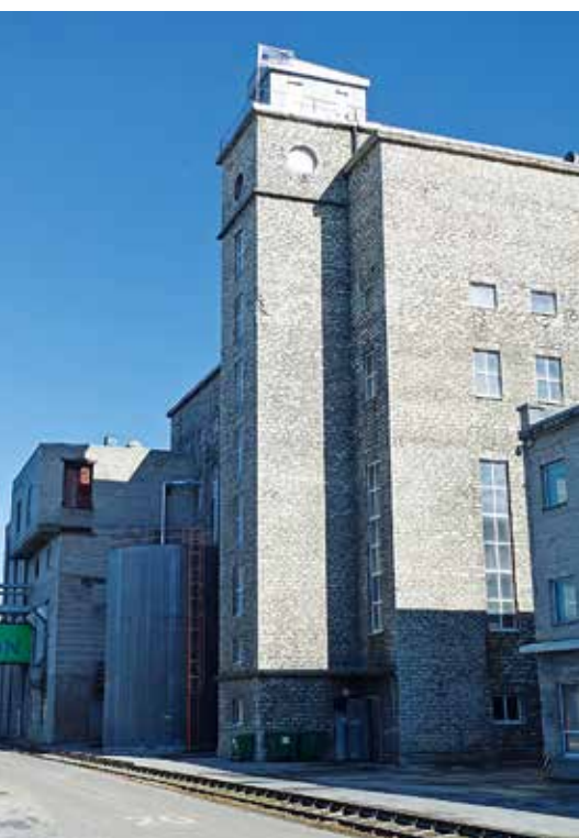
< Arhitektide Johann Ostrati ning inseneride Ferdinand Adoffi, August Komendandi ja Voldemar Kase funktsionaalne projektsioon Kõrre Tööstusettehase hooned ehitati 1937–1938. Pärast teist maailmasõda ja 2000. aastail on tehases palju ümber ja juurde ehitatud. Tehase väljapaistvaim osa, paekivist tselluloositehase keeduhuone, on säilinud üpris ehedal kujul. (Foto: Heiki Pärdi, 2023)
