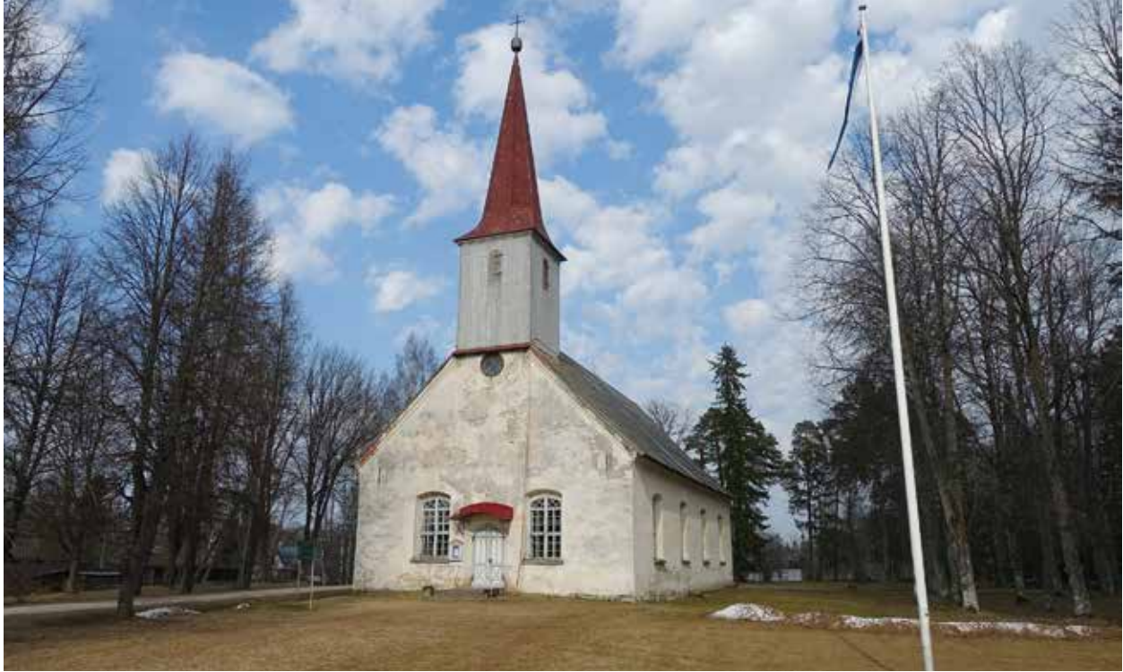
Vändra Martini kiriku ehitas Pärnu ehitusmeister Stahmer, 1841 lisati torn. (Foto: H. Pärdi, 2018)
