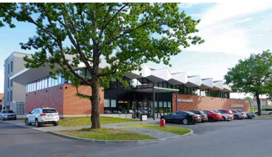
◀ Üks Eesti modernistliku arhitektuuri tähtteoseid oli 1968. aastal valminud Saku instituudi näitusepaviljon. Vahepeal aastateks saatuse hoolde jäetud hoone sai 2020 uue elu Saku vallamajana (arhitektid Karmo Tõra ja Alar Oruvee, sisearhitekt Riina Luuk). (Foto: Heiki Pärdi, 2021)
