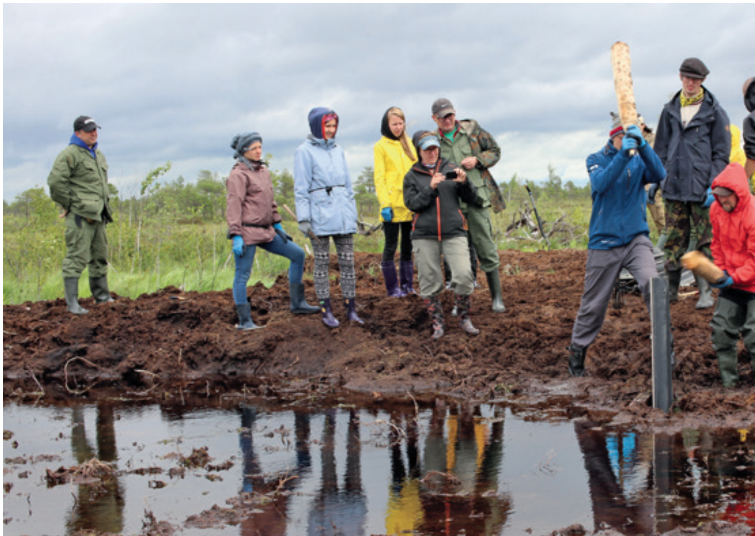
Meil ei jätkunud vasaraid, et tõkkeid turbasse kinni tagada, seetõttu valmistasime kohapeal puitvasarad
