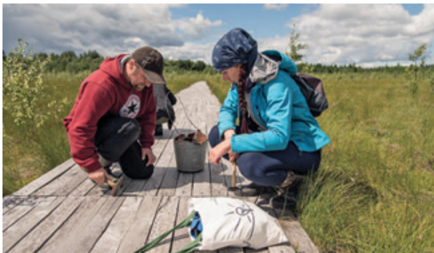
Jelnja raba loodusõpperaja laudteel leidsid siin-seal lahtisi laudu, mida naeltega kinni lõime
