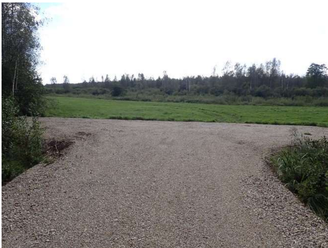
Joonis 11. Killustikuga kindlustatud pealesõit Mustjõe luhale
