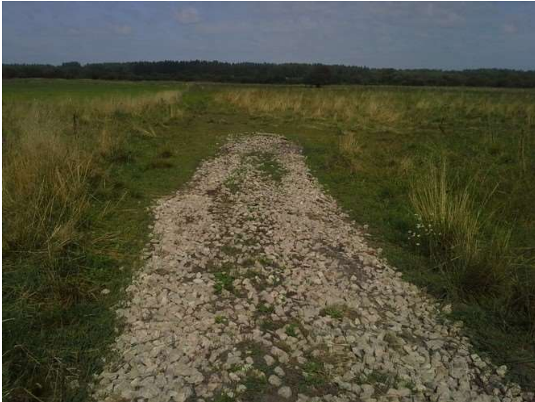
Joonis 11. Killustikuga kindlustatud pealesõit Mustjõe luhale
