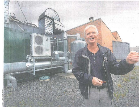
Her viser overingeniør Knut Berg-Larsen stolt frem Arendal kommunes nye kraftverk. Ved hjelp av innbyggernes kloakk produseres massevis av strøm. Nå viser andre kommuner interesse for prosjektet. NYHETER side 4-5
