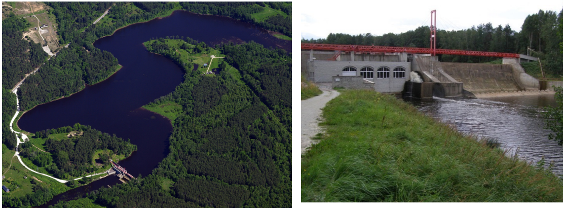
Joonis 2. Fotod kajastavad tänast olukorda, kui Linnamäe paisjärv jääb alles ja jätkub elektritootmine (Autor: Mait Metsur (Aerofotod.ee), Autor: Urmas Nugini Inseneribüroo)
