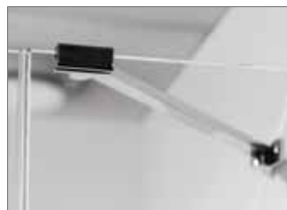
Наклонная балка (KT) - Wall upper supporting bar with adjustable angle
