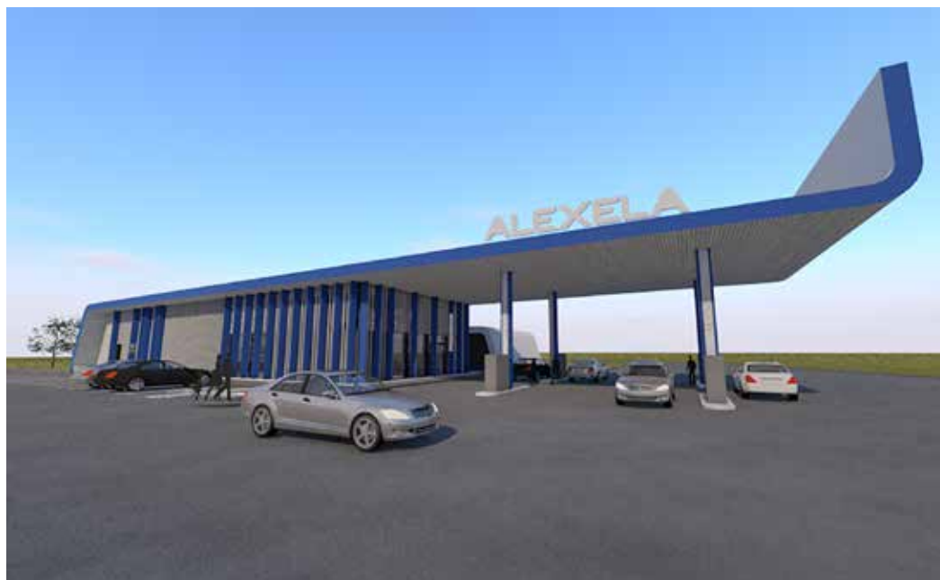
Foto: OÜ Arhitektuuribüroo Luhse & Tuhal
