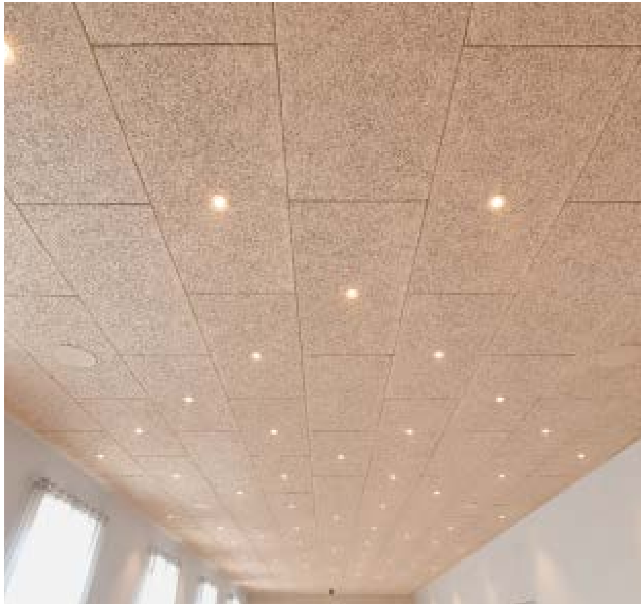
Luminaires intégrés au plafond
