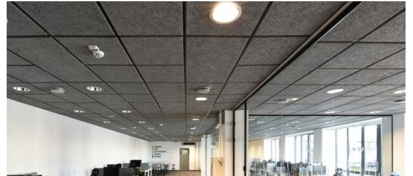
Structure profilé de type T, profilé de bord POG, panneau acoustique CEWOOD de 25 mm
