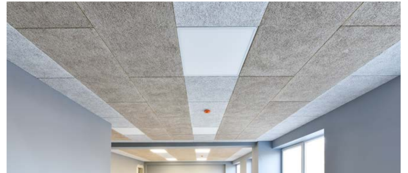
Structure profilé de type T, profilé de bord POG, panneau acoustique CEWOOD de 25 mm
