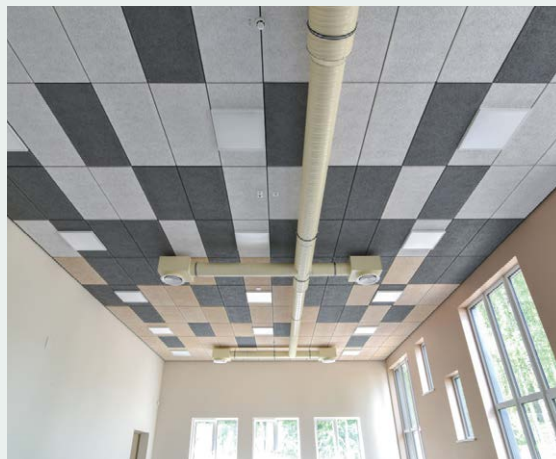
Griestu apdare ar CEWOOD plātnēm, nodrošinot 10 mm atstarpi starp plātnēm.
