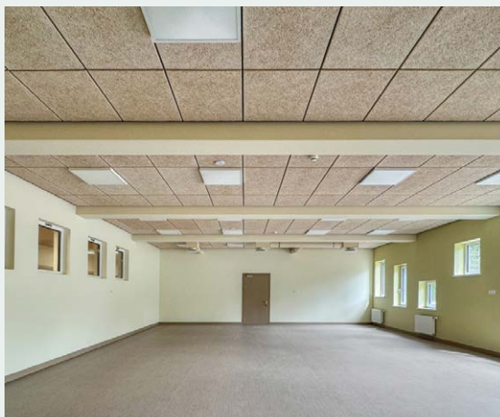
Griestu apdare ar CEWOOD plātnēm, nodrošinot 10 mm atstarpi starp plātnēm.
