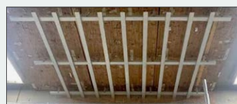
600x600 mm paneli stiprināmi ar 6 skrūvēm.
