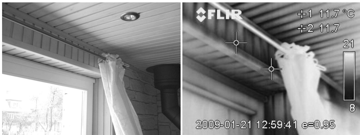
Joonis 56. Lekkekohtade visualiseerimine termokaameraga (alarõhu tingimustes, renoveeritud hoone). Näha avatäite paigaldusest tingitud õhulekked siseruumi.
