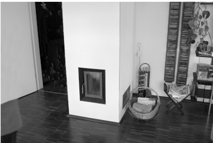
Joonis 11. Passiivmajastandardiga pereelamu näide, kus sooja vee ja ruumide kütteks kasutatakse halupuudega köetavat kaminahju koos integreeritud sooja koguva päikesekollektor-süsteemiga (Nürnberg, Saksamaa).
