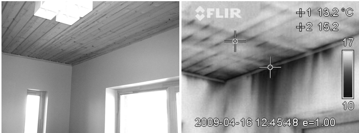
Joonis 55. Lekkekohtade visualiseerimine termokaameraga (alarõhu tingimustes, kasutuses olev hoone). Näha vahelae ja seina ühenduskohast põhjustatud õhulekked siseruumi.
