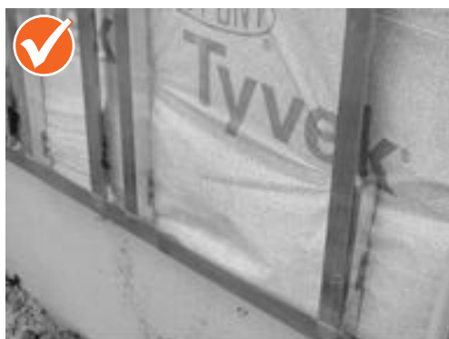
L-profiili õige paigaldus vertikaalsele vuugile
