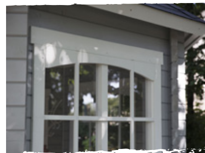
Portes et fenêtres bien vitrées
