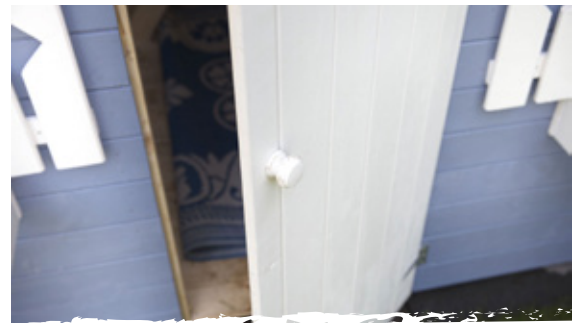
Porte simple pivotante avec fermeture magnétique empêche toute obstruction involontaire
