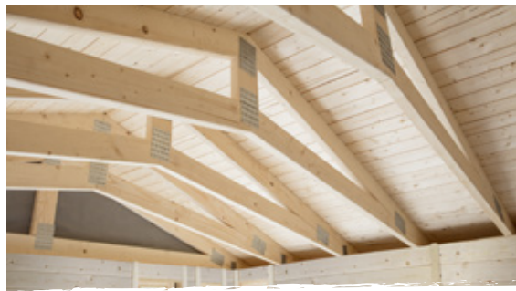
Construction de toit par méthode à chevrons pour des charges maximale.
