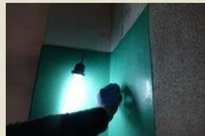
Se o tadelakt estiver numa superfície frequentemente exposta à água, a superfície terá de ser ensaboada e polida depois de 2 ou 3 dias de carbonatação, com uma esponja coberta com plástico fino (por ex. um pedaço de saco de plástico transparente) ou com um tecido macio. Quando o tadelakt estiver
