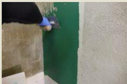
A primeira camada é de cerca de 2-3 mm de espessura e é aplicada no suporte com uma talocha de plástico, ou de metal ou com espátula (foto 34). O reboco aplicado deve ser talochado imediatamente com uma talocha de poliuretano ou de madeira, para que o reboco possa entrar nos poros da superfície e consiga uma ligação bem coesa (foto 35). Talochar faz com que a camada fique mais nivelada e com que a superfície fique rugosa e porosa adequada à aplicação da segunda camada (foto 36).
