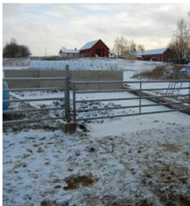
Betooneeritud tahke sõnniku hoidla.
