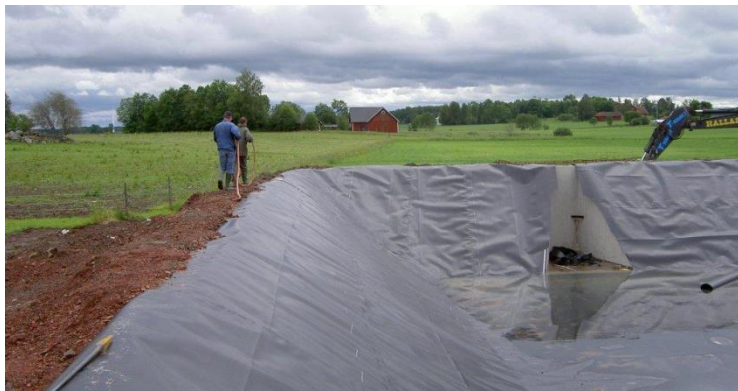
Hermeetilise polüeteenvooderdisega sõnnikuhoidla konstrueerimine.
