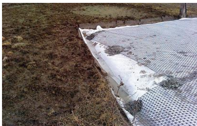
Geotekstiili ja -võrgu servad on kinnitamiseks alla keeratud selleks kaevatud kraavi.
