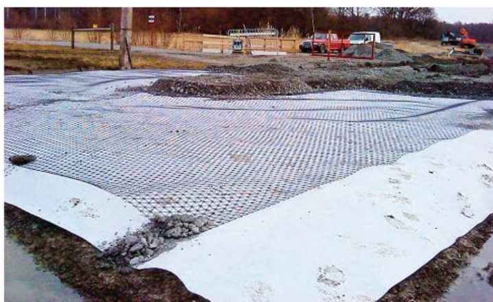
Geotekstiil ja -võrk takistavad allpool oleval kruusa- ja liivakihi liikumist ülespoole kui kariloomad sellel liiguvad. Geotekstiil laotatakse siledale alale. Tekstiilile laotatud geovõrk kaitseb maapinda ja tugevdab rajatist.
