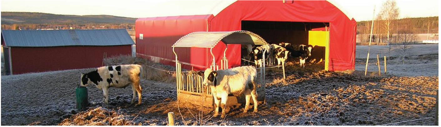
Lihtne ehitis (varjualune) koos söötmisala ja jootmiskohaga. Maapind on tugevdatud geotekstiili ning kruusaga.
