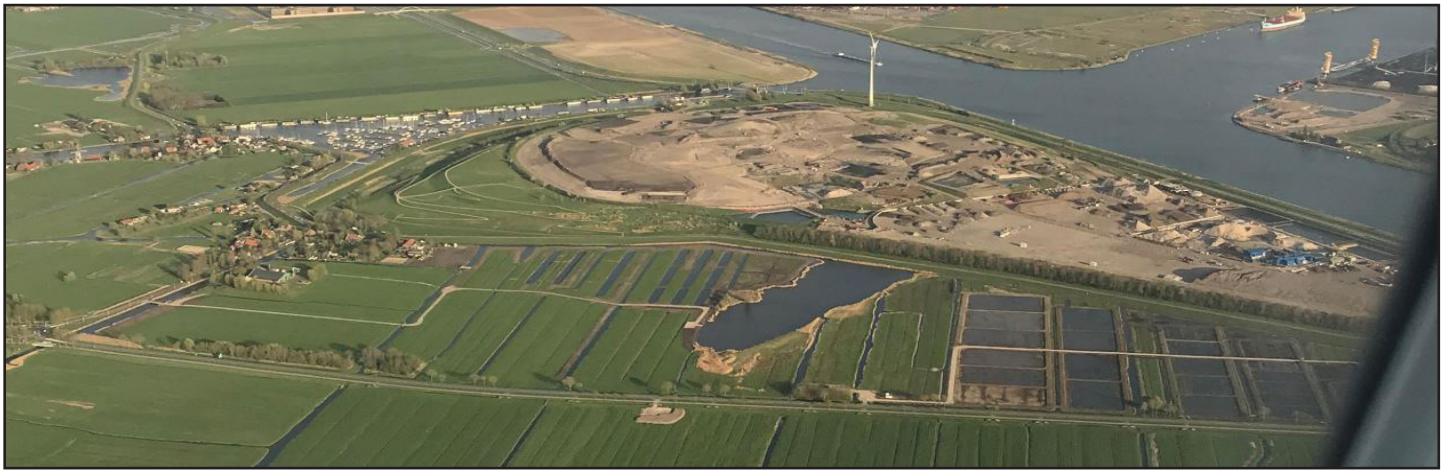
Aerial view Polder Zuiderveen
